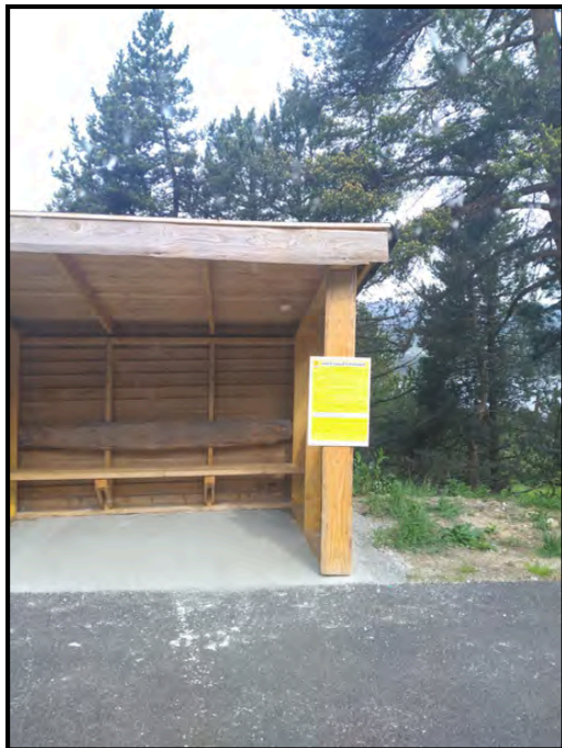
12. Arrêt de bus RD 118 lotissement du Lac
