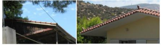
Αναπαράθεση κεραμικών στεγών. Αριστερά στέγη με έλλυνο υπόβαθρο, εύφλεκτη. Δεξιά, τοιμενένια, δεν αναφλέγεται. Και στις δύο περιπτώσεις η βλάστηση ακουμπά στις στέγες.
