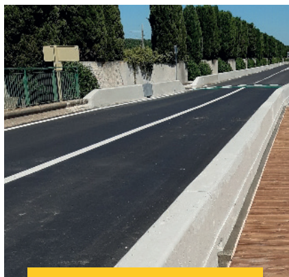
Passerelle de la véloroute sur l'Agouille de la Mar à Corneilla-del-Vercol
