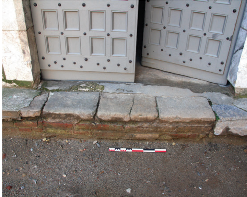
52 - Dalles en grès, en remploi dans le seuil de la porte d'accès à la salle basse (aile méridionale).
