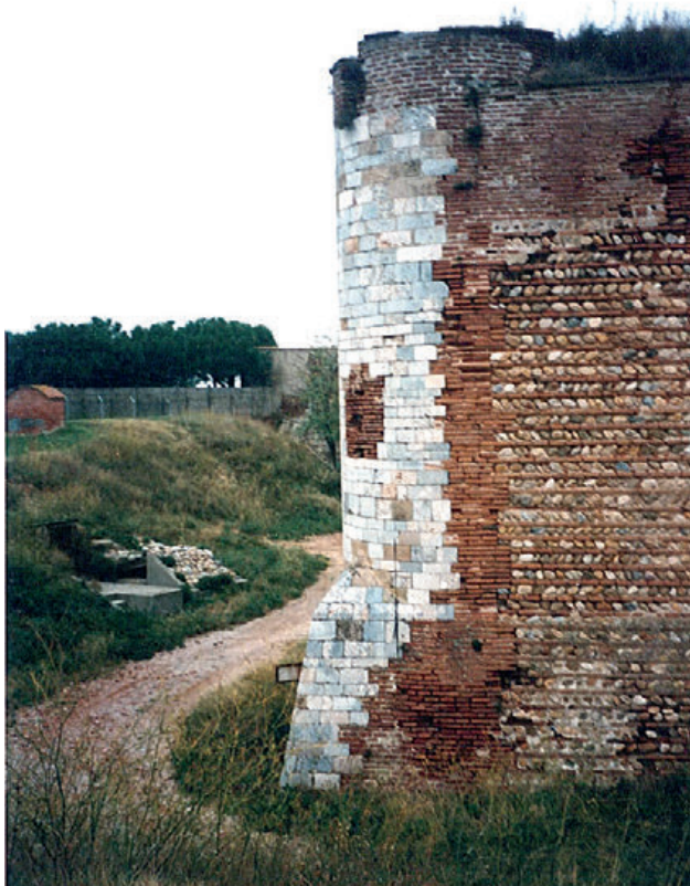
14 - L'avancée défensive, détails de l'angle du bastion sud-ouest bâti en pierre de taille de Baixas, état 1996 (cl. de l'auteur).
