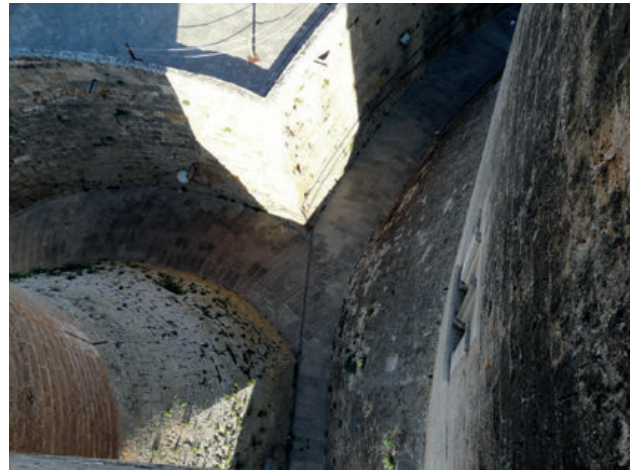
39 - Torre i talús, obrats en pedra, del castell de Bellver.
