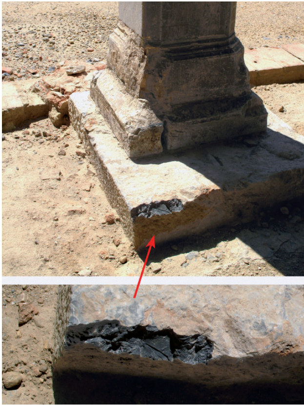
10 - Pilier central de la cour d'honneur soutenant les voûtes en brèche de Baixas qui portent la galerie orientale. On remarque que la fondation dégagée lors des récents travaux de restauration et fouilles archéologiques est composée de gros blocs de calcaire urgonien homogène de couleur gris foncé à noir.
