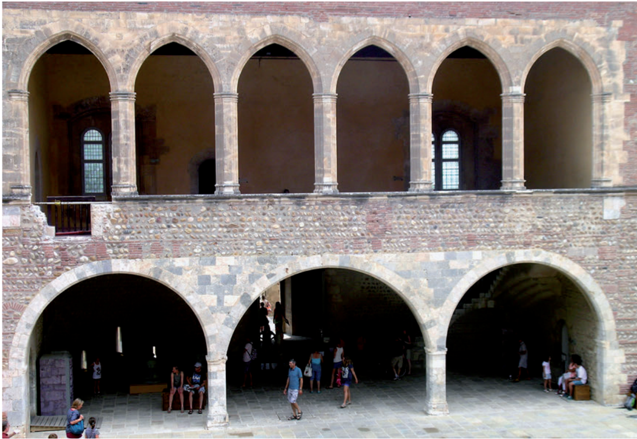
23 - Aile occidentale de la cour d'honneur, arcades du porche d'entrée en brèche de Baixas plus ou moins blanche et galerie gothique du Palais blanc en « pierre du lac », où se trouvait la salle du trône.
