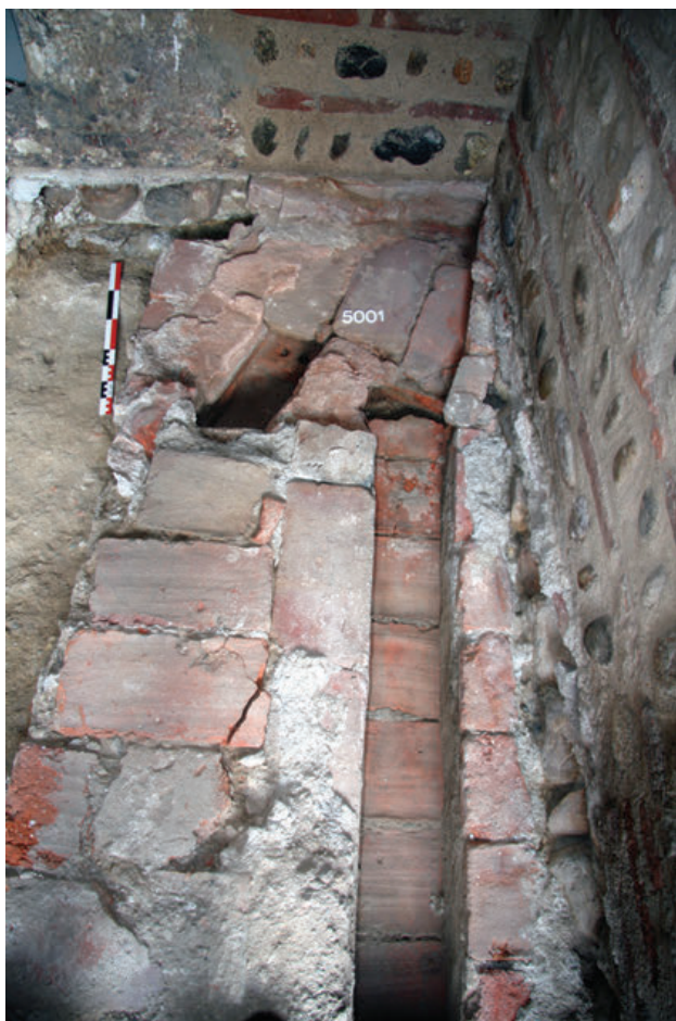
22 - Regard de répartition du caniveau CN 4027/5003.
