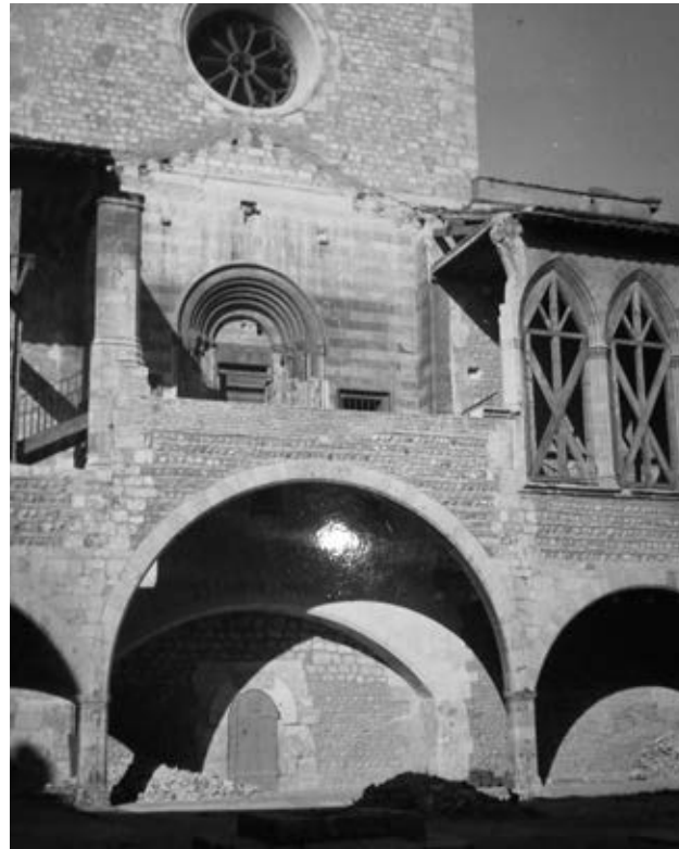
15 - Début 1950. Après démontage de la toiture en appentis, la silhouette du pignon en marbre et les encastresments de l'ancienne charpente apparaissent. Photo Stym-Popper.
