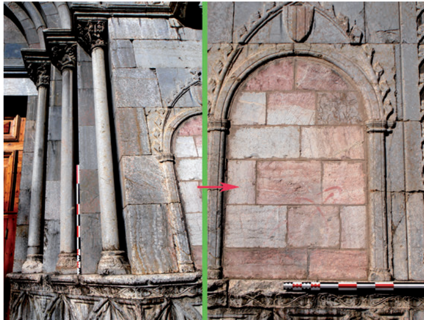
54 - Puigcerdà, portail du couvent des Dominicains. Variation des marbres cloisonnés d'Isovòl (de type « FP ») à gauche, dans les tons bleutés ou blancs pour les colonnes. À droite, détail de l'arcature où les variétés de cette même roche, plus rouges, et plus rares, sont celles qui furent utilisées pour le portail gothique de l'église Sainte-Marie.
