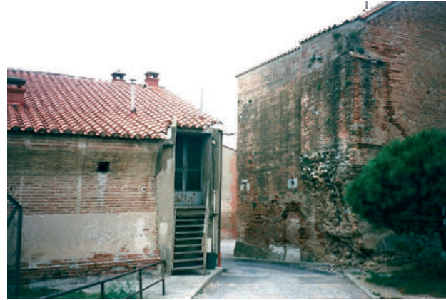
5 - Angle sud-est de l'enceinte entourant le Palais des rois de Majorque, à droite le bâtiment de l'angle sud-est en brique et le massif de maçonnerie en arrachement matérialisant la jonction de la courtine. Au premier plan, vestige de la courtine couronnée par le chemin de ronde dont on voit le départ de l'encorbellement, état 1996 (cl. de l'auteur).
