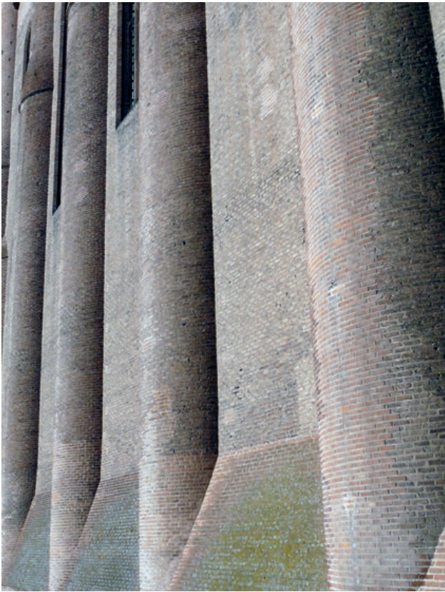
36 - Contraforts arrodonits de la catedral d'Albí (Tarn), c. 1280-1300.
