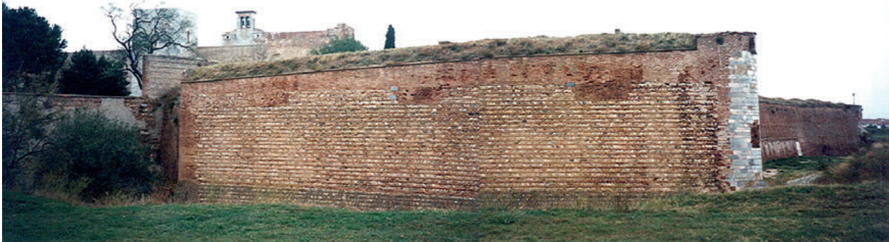
13 - L'avancée défensive, ensemble du flanc du bastion sud-ouest, réalisé en maçonnerie mixte, galet et cayrou, état 1996 (cl. de l'auteur).
