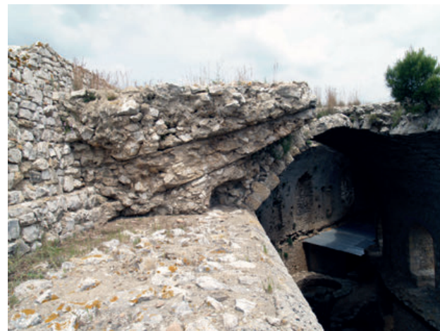
24 - Chloumoutzi-Clermont, hexagone, grande salle, voûte : extrados en bâtière exhaussé et aménagé en terrasse.
