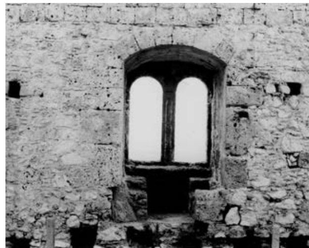
43 - Chloumoutzi-Clermont, hexagone, bâtiment d, fenêtre géminée.
