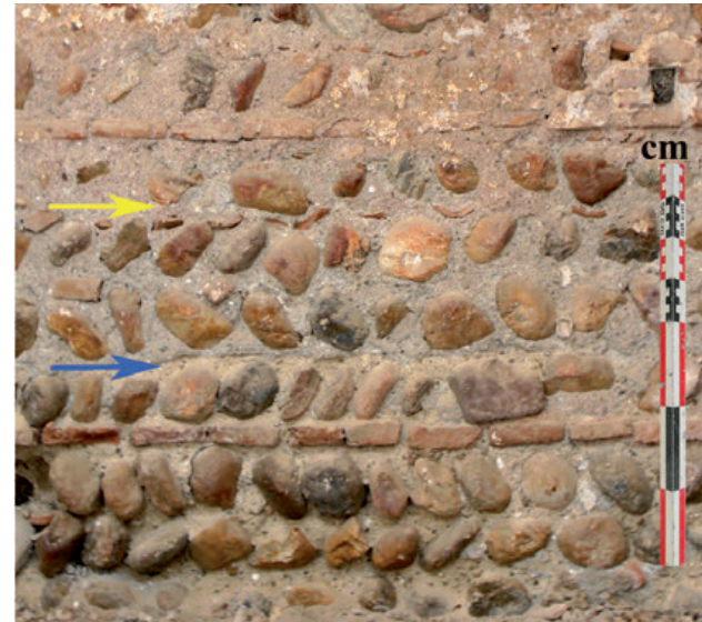
23 - Église des Carmes, détail du gros œuvre. Le mur de la façade occidentale (à gauche) comporte de gros galets de quartz cassés au marteau et quelques calages de tuiles. Sur la façade nord de la première chapelle (à droite), les galets de quartz patinés sont disposés en plusieurs rangs entre des assises de briques sans être forcément associables au montage : entre deux arases de briques s'observe un net changement dans la couleur du mortier (flèche bleue) et un litage de cales en tuile (flèche jaune) sous le dernier rang (cl. C. Respaut).
