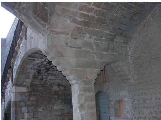
46 - Retombée des arcs de l'escalier nord et du portique des chapelles. Cl. B. Pousthomis.
