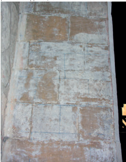
26 - Faux appareil sous l'arc du podium de la chapelle haute. Cl. B. Pousthomis.
