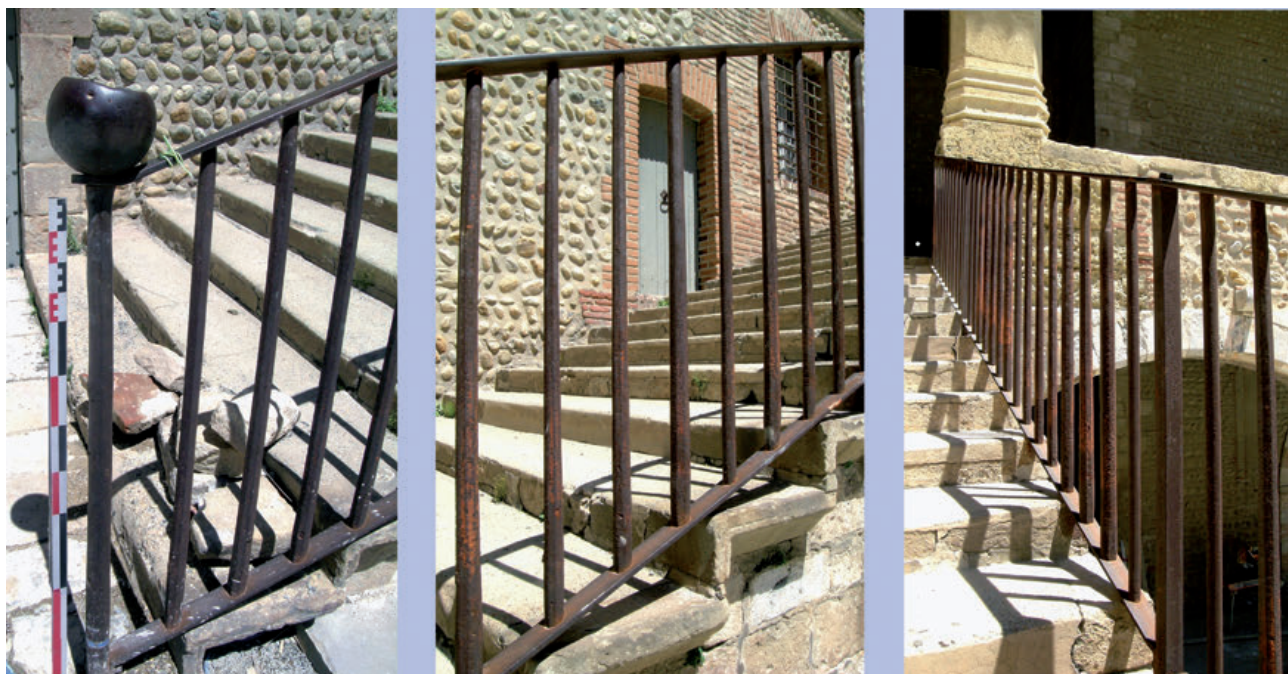
16 - Les rampes des escaliers de la cour d'Honneur donnant sur la galerie de la chapelle haute, sur les appartements du roi et la salle de Majorque ont été réalisées avec des canons de mousquet de différents modèles dont on aperçoit la lumière permettant la mise à feu à l'emplacement du bassinet (trou en bas, vue du centre). Sur la vue de gauche, ornant le premier barreau, un boulet creux de bombe, également muni d'une lumière pour sa mise à feu (la pièce a été brisée).
