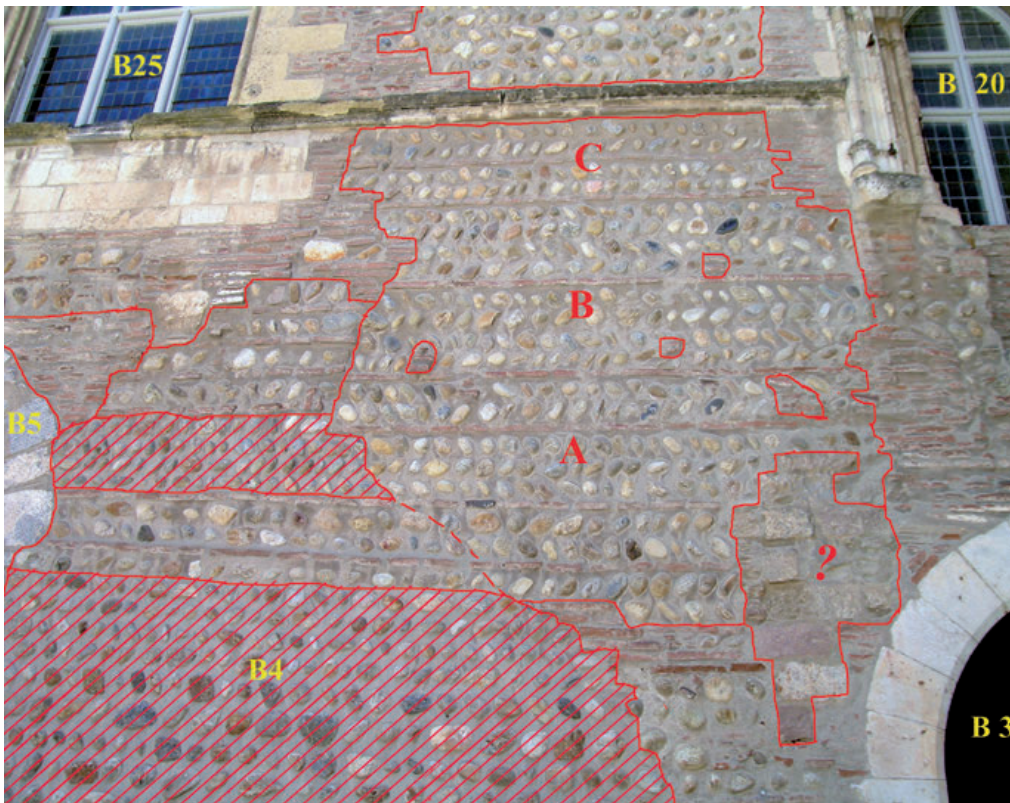
13 - Façade du premier logis du roi, dans la cour d'honneur du château royal. Les parties hachurées ont été reconstruites à la place du portail B4 lors des restaurations (test M3, tableau 4). La zone parementée est notée : « ? » et les parties testées avec A, B et C. La porte B20 (tiers-point) en calcaire blanc de Sigean est venue perturber la façade au XIII e siècle, bien avant la création de la baie B5 (brèche de Baixas) et la restauration (XV e -XVI e siècle?) de la grande baie B25 avec des molasses coquillères jaunâtres.
