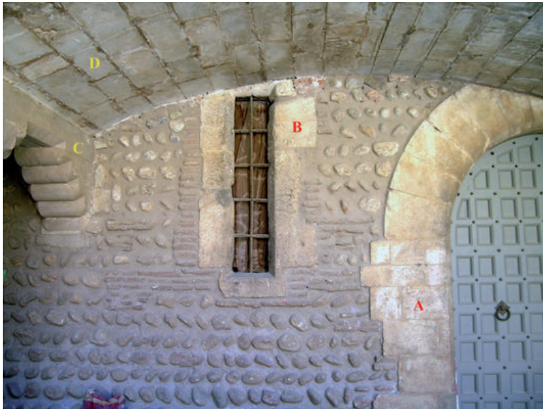
16 - Portail B11 en marbre blanc de Baixas (A) sous l'escalier sud de la grande cour (D). Au-dessus du mur en galets typiques d'une phase ancienne du chantier se trouve une fenêtre (B), elle aussi recoupée par la voûte, mais taillée dans un calcaire tendre et blanc, du type « pierre du lac ». En C, l'une des piles de l'escalier en grès siliceux du Boulou.
