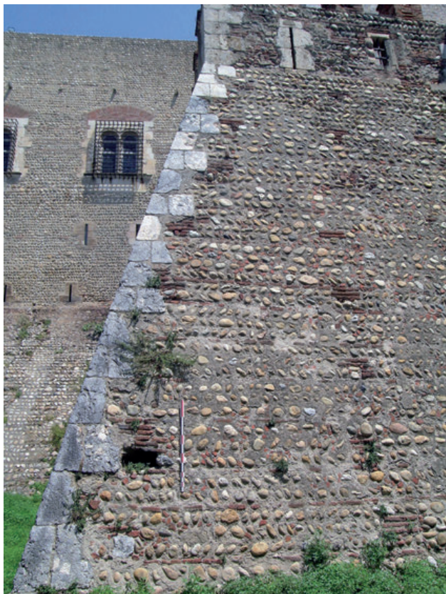
12 - Le talus d'escarpe de la barbacane du château royal. L'angle nord est renforcé par des parements de brèche de Baixas où la part du faciès calcaire « cristallin » gris-bleuté et compact domine. Quelques blocs de brèche dite « orientale » sont plus mouchetés de blanc et d'autres, plus rares encore, vers le haut, sont très blancs (brèche dite « romaine »).
