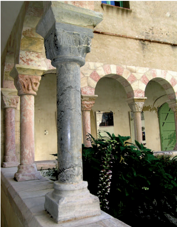
52 - Cloître de Saint-Génis-des-Fontaines. La colonne au premier plan est une variété noire des marbres cloisonnés de Villefranche.
