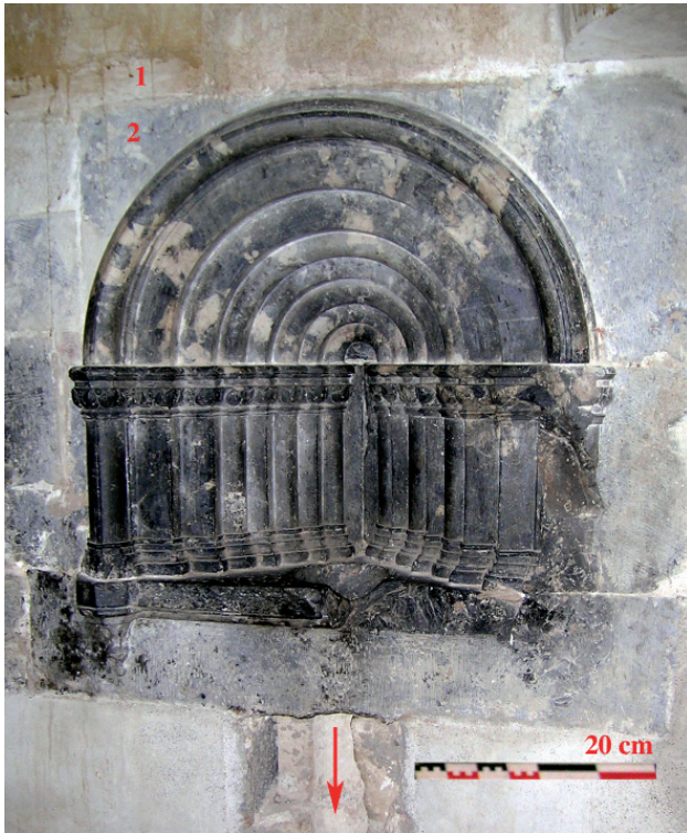
30 - Lave-main de la chapelle Sainte-Croix sculpté dans la brèche orientale de Baixas et dont le motif évoque le portail d'une église romane. L'encadrement est réalisé dans la même roche que celle des murs, des moulures et sculptures des culs de lampes et des clés de voûte. La partie basse, celle qui est destinée à être éclaboussée par l'eau et plus vite usée, est prise dans les parties les plus sombres de ce matériau, formé d'un calcaire métamorphisé d'un gris bleuté très foncé et qui, par son usage dans le bâti médiéval, montre qu'il était considéré comme dur et très résistant.
