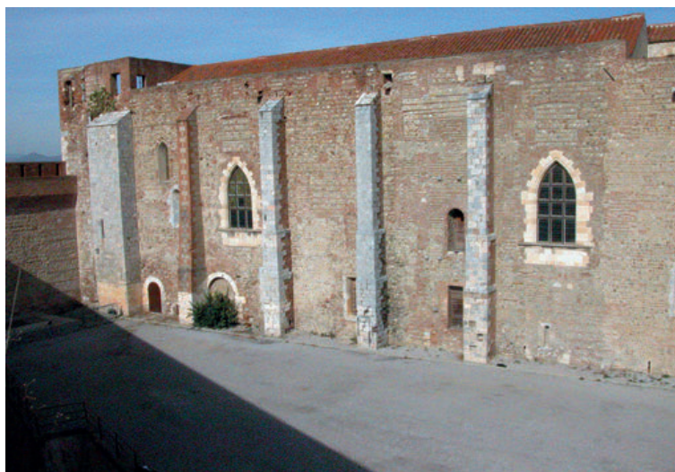
11 - Aile sud. Façade extérieure. Cl. A. Marin.
