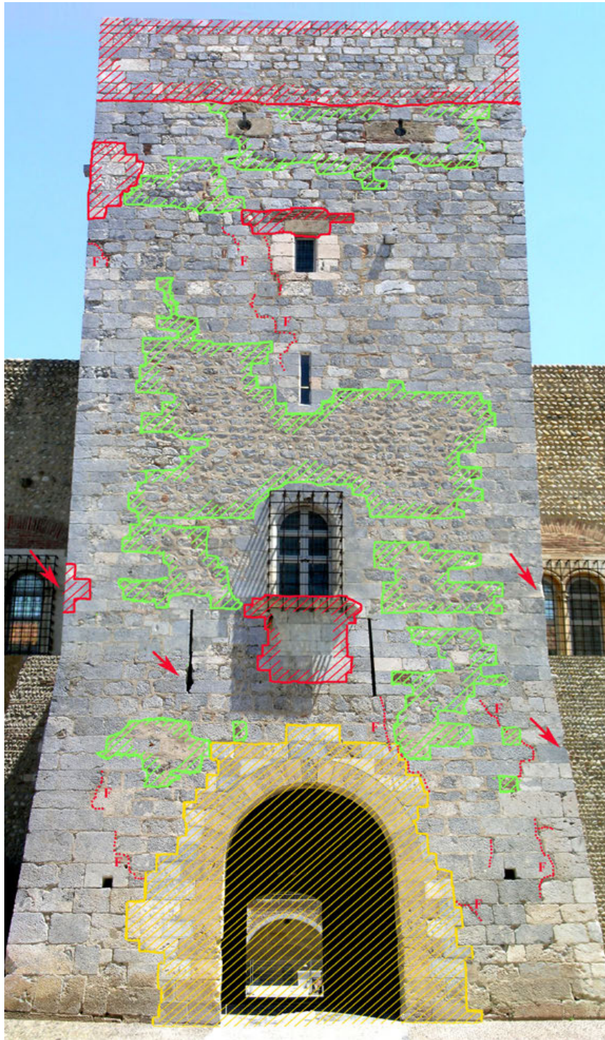
7 - Façade occidentale actuelle de la tour de l'hommage (l'empattement vers la base est une distorsion photographique). Les remaniements contemporains (en rouge) se rapportent aux assises du sommet, à la fenêtre grillagée du bas et à l'angle abîmé à gauche (restaurations 1952) ainsi qu'au linteau d'une fenêtre haute réparée en 1853 (gravure sur linteau). Ceux d'époque moderne, entre 1686 et 1824 d'après les plans anciens (en jaune), concernent le portail d'entrée ( pedra de Les Fonts , usage de la boucharde). Les remaniements antérieurs (en vert), dont les deux canonnières ajoutées entre 1478 et 1486, (voir ill. 8), sont des perturbations du bâti difficiles à caractériser. Les fissures et les élargissements des joints (F) sont indiqués en rouge par des pointillés et les impacts par des flèches.
