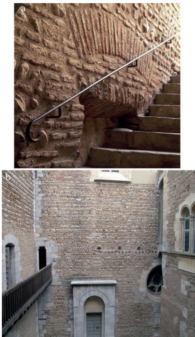
3 - a. Jour quadrangulaire en briques recoupé par l'escalier conduisant de l'entresol à la galerie de la reine. Cette ouverture est typique d'une phase primitive de construction sans que l'on sache si les briques de grande dimension étaient apparentes ou si l'ensemble était recouvert d'un enduit. b. Plus haut, les briques d'un module courant encore utilisé au XVI e siècle (20 x 40 x 5 cm) forment des lits ( cairos ), séparant les bandes d'arase formées de galets parfois disposés en épis simple ou double. Un premier examen de ces cailloux roulés dans les parties les moins remaniées du bâti montre une bonne proportion de galets de quartz, de quartzites et de cornéennes patinés, très probablement issus des très vieilles terrasses quaternaires qui entouraient alors le Puig del Rey . À cette provenance immédiate s'ajoute une part notable de galets de quartz non patinés, mais aussi de gneiss et de granites, roches issues du Canigou que l'érosion chimique a épargné uniquement sur les terrasses plus récentes du plan de Thuir (cl. Agnès Marin 2007).
