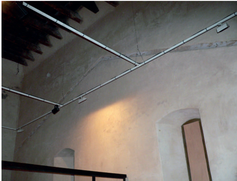
39 - Revers du mur ouest de l'aile sud. Solin de toiture et baies appartenant au mur pignon ouest du logis primitif du roi. Cl. A. Marin.
