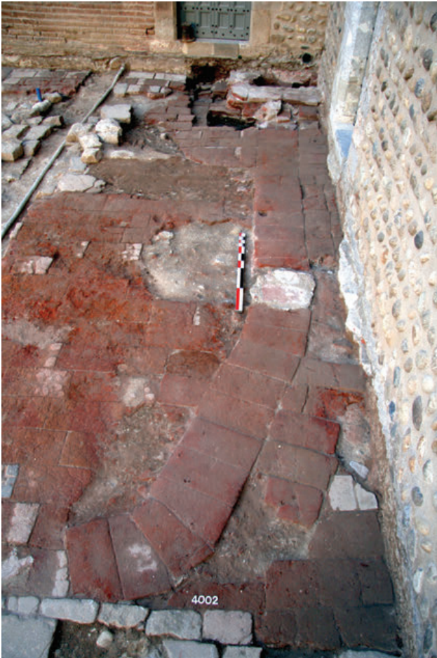
19 - Caniveau CN 4002 avec en haut le regard de répartition PT 4001.
