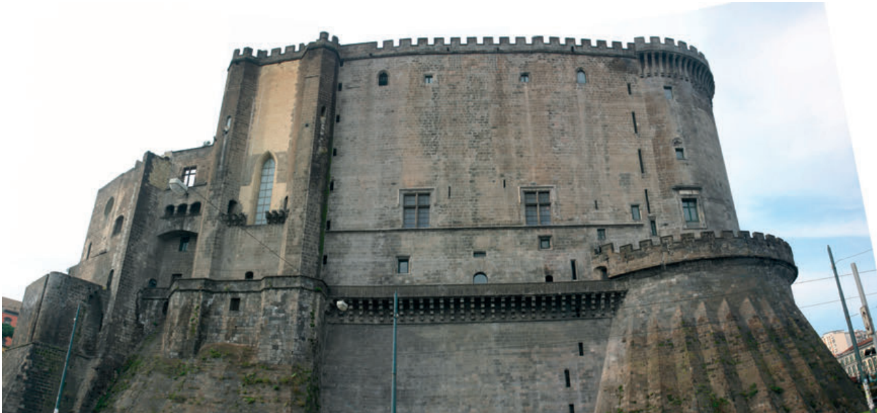
3 - Naples (Italie). Castel Nuovo : vue du château depuis l'ouest. La chapelle angevine est reconnaissable à son haut chevet plat cantonné par deux tourelles polygonales ; à sa droite, la façade occidentale de la grande salle aragonaise (cl. Mesqui 2005).
