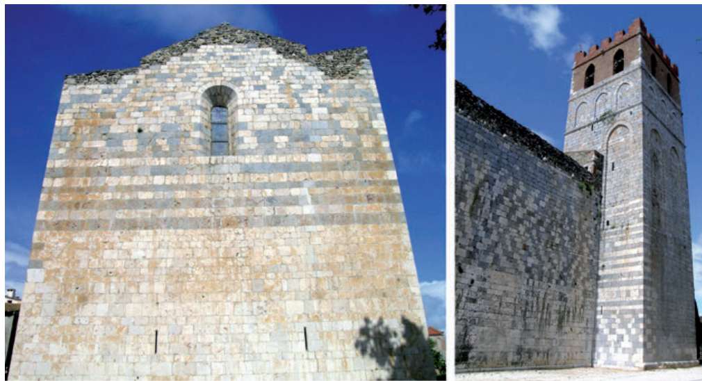
26 - Aspects de l'église fortifiée d'Espira-de-l'Agly. Vue du chevet plat (à gauche) et d'une partie du mur nord avec son clocher-tour.
