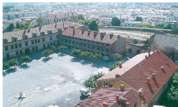
33 - Caserne d'Andalousie, au second plan, à droite, bâtiment de l'angle sud-est (archives du Service Territorial des Pyrénées-Orientales).
