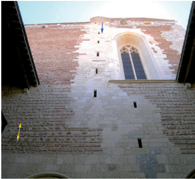
21 - Façade septentrionale de la tour des chapelles au château royal. Les rangées de plus gros galets entre les chaînages de briques sont indiquées par une double flèche jaune. En haut de la partie blanche, parementée avec les calcaires lacustres de Sigean et qui correspond à l'escalier à vis conduisant au sommet de la tour, la flèche bleue indique un probable impact de boulet qui pourrait dater des conflits lors de l'occupation française entre 1462 et 1475.
