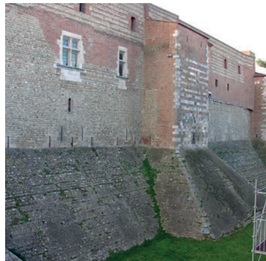
15 - Aile nord. Façade extérieure. Cl. B. Pousthomis.
