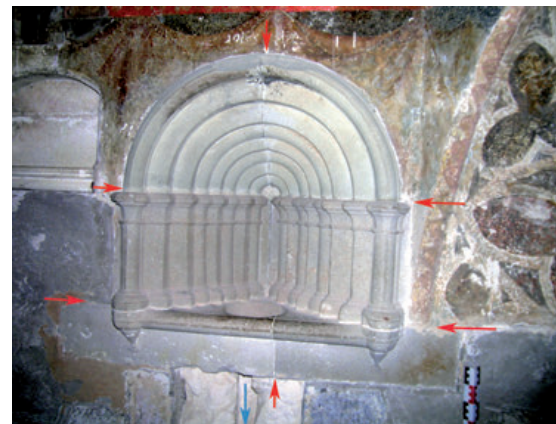
11 - Custode (à gauche) et piscine de la chapelle basse taillées dans six blocs de grès siliceux (jonctions signalées par des flèches rouges); l'assemblage forme un décor d'archivoltes évoquant un portail roman. Le lavabo situé dans la sacristie est également taillé dans cette roche. Ici, l'eau s'écoulait dans la fondation par une canalisation verticale creusée dans la « pierre du lac » (flèche bleue) probablement laissée à nu. Les parements visibles sont en marbre bleu de Baixas. Sous le décor peint, ils sont dans cette même roche ou en calcaire de Sigean (cl. G. Lanuzel, AAPO).
