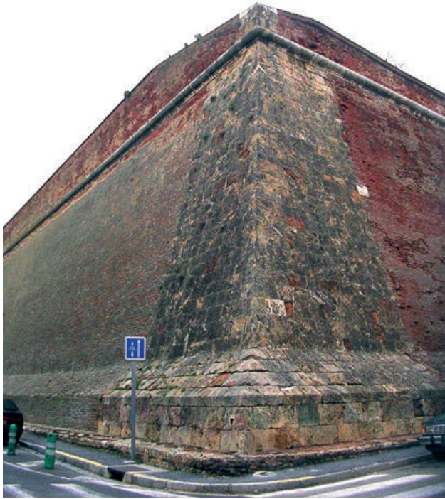
22 - Bastion Saint-Mathieu, angle extérieur en pierre de taille de Les Fonts , état actuel (cl. de l'auteur).
