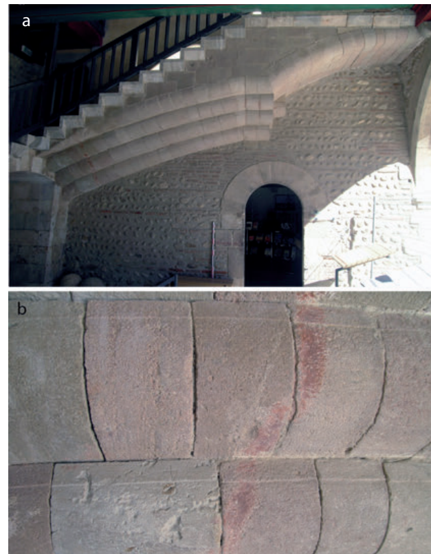
5 - a. Escalier en grès du Boulou donnant accès au palais blanc, salle du trône à l'époque des rois de Majorque; b. détail avec signes lapidaires.
