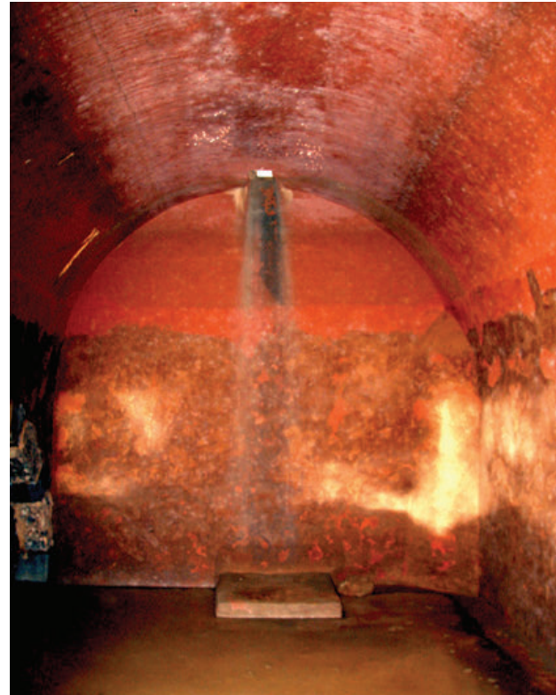
13 - Arrivée d'eau, aménagée sous les voûtes et dalle quadrangulaire protégeant le sol de la citerne.
