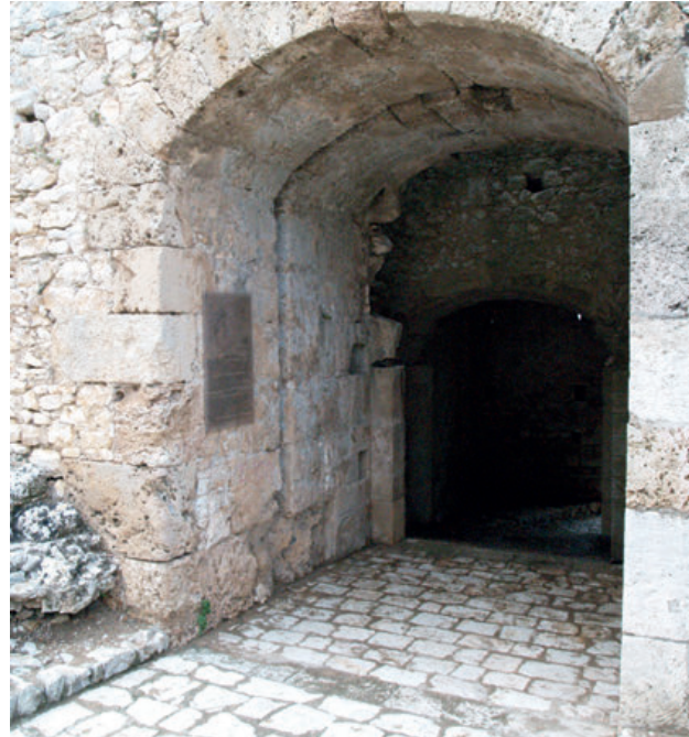
15 - Chloumoutzi-Clermont, enceinte extérieure, la porte vue de l'intérieur.
