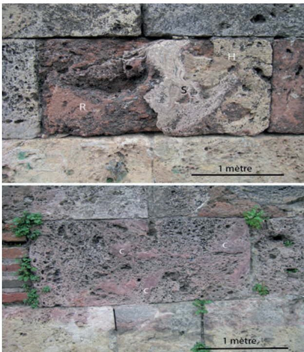
15 - a. une grande pierre de taille des remparts montre le contact stratigraphique entre les formations rouges du Rhétien (R) et la cargneule de l'Hettangien (H), la discontinuité est soulignée par le développement stromatolithique (S) d'environ 30 cm de Microcodium , une telle pierre ne peut provenir que du secteur du Crest Petit ; b. une autre pierre de cargneule des remparts où le toit rouge du Rhétien a été remanié sous forme de clastes inclus dans l'Hettangien.
