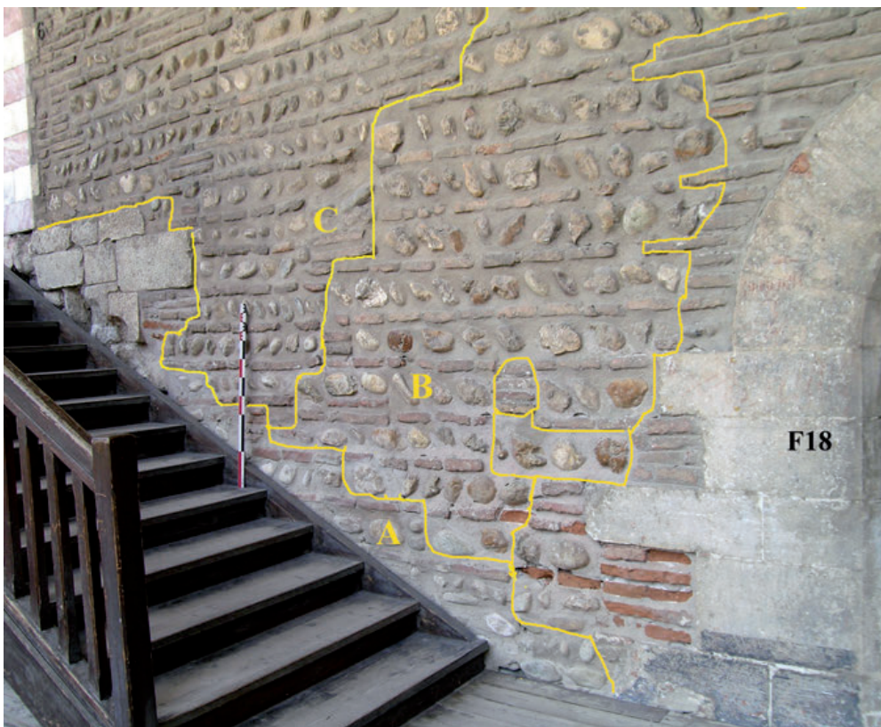
17 - Mur F de séparation des cours au château royal, face donnant sur la grande cour, dans la galerie des chapelles. Entre la porte F18 (insérée après la construction du mur de séparation) et le mur-contrefort de la chapelle haute plaqué de marbre rouge et blanc, au-dessus des anciens ancrages de l'escalier en pierre conduisant au parvis de la chapelle Sainte-Croix (A), la jonction entre la partie en attente (B) et celle qui a rejoint le mur-contrefort encadrant la façade des chapelles (C) est visible en biais jusqu'au toit.
