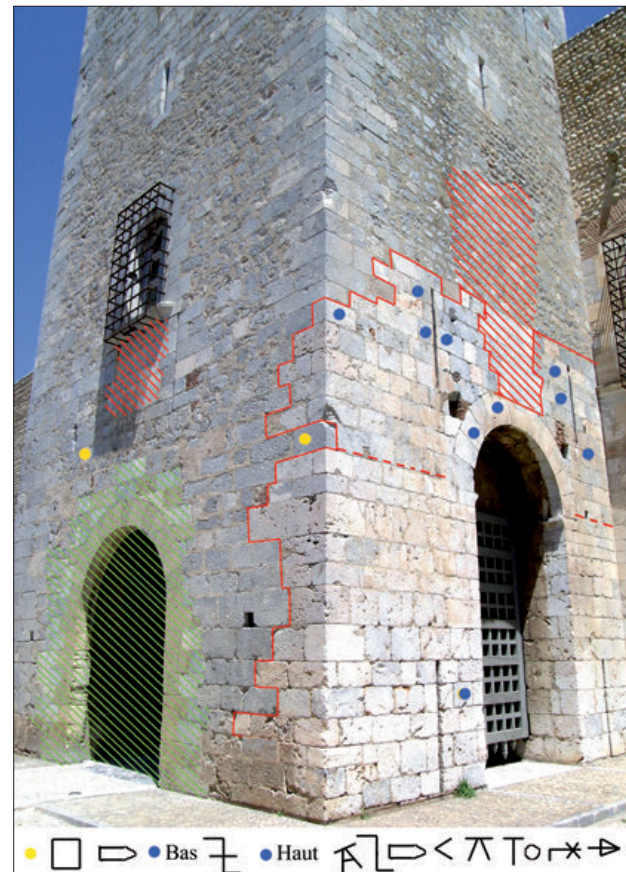
22 - Portail extérieur de la tour de l'hommage muni d'une herse. Les points indiquent la répartition des signes lapidaires, plus nombreux près du portail, sur la face sud. Les tirets indiquent une rupture dans la coloration correspondant à un manque de roches blanches. Les hachures indiquent les parties fortement remaniées : en vert, avant 1800, en rouge, après 1950.
