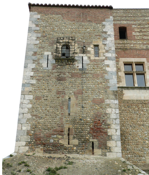
2 - Façade nord de l'aile nord. Exemple de phasage chronologique. Dessin A. Marin et F. Escande. Voir ci-dessous le détail de la tour nord-est.
