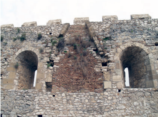
13 - Chloumoutzi-Clermont, basse-cour, bâtiment 3B, foyer et ouvertures.
