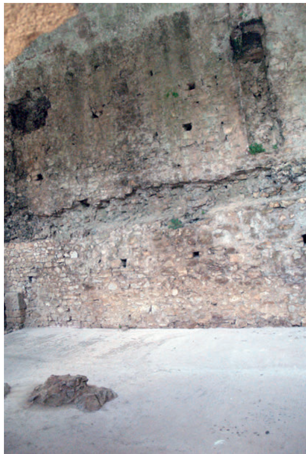
49 - Chloumoutzi-Clermont, hexagone, aile 1/b, creusement du mur pour l'application de la voûte.
