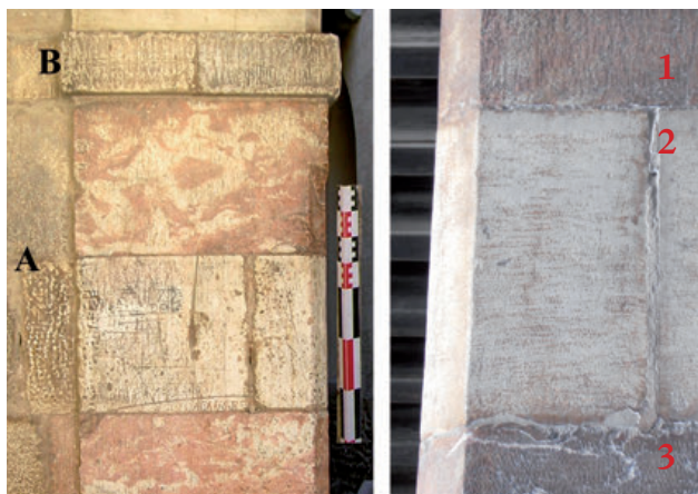
59 - Portail F5 de la cour d'honneur. À gauche, le montant nord avec les parties layées sur le tailloir (B) et bouchardées (A, décrochement pour l'enduit). À droite les claveaux de la voûte layés à la gradine (1, 2) ou avec un taillant à brettüre? (3) - (cl. C. Respaut, AAPO).
