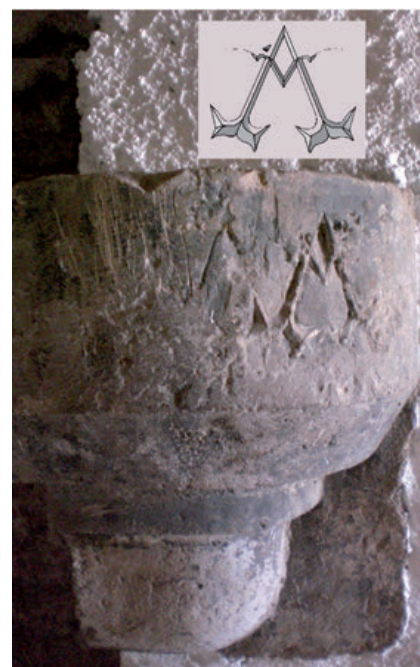
4 - Signature du tailleur de pierre sur le corbeau droit du manteau de la cheminée H12, datable du milieu du XV e siècle (Marin, vol.6 p.86); le dessin est reproduit dans la vignette (cl. J.-P. Alazet, CG des P-O).
