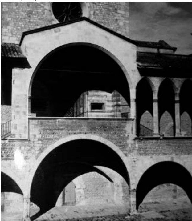
16 - Juin 1950. L'arc est reconstruit. La partie nord de la galerie, avec les piliers droits, est maintenue. Photo Stym-Popper.
