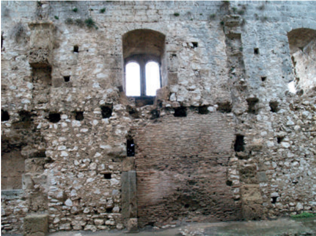
7 - Chloumoutzi-Clermont, hexagone, aile 4d : vestiges du bâtiment initial.
