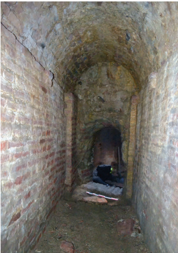
67 - Le souterrain d'accès au puits à glace.
