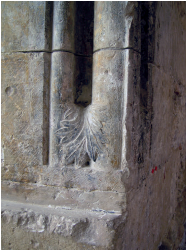
21 - Logis au sud du palais blanc construite en calcaire blanc de Sigean ici à patine jaunâtre. Ce calcaire très tendre et homogène se prêtait parfaitement aux sculptures les plus délicates, ici moulure et sculpture d'une feuille de vigne symbolique sur une baie. Mais il était aussi fragile et parfois affecté par une forte porosité qui, en fonction de l'exposition aux agents climatiques, est à la source d'effritements préoccupants.
