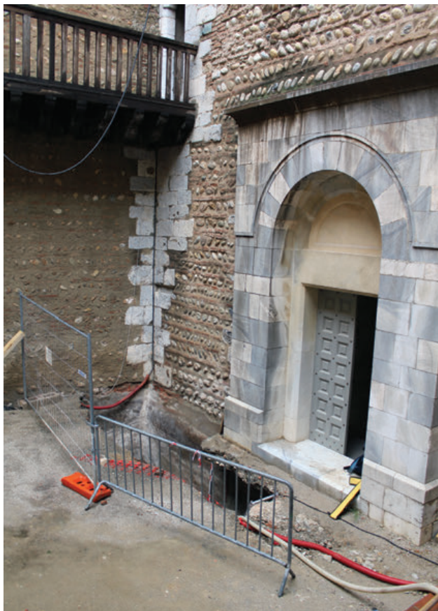
43 - Citerne découverte en 2011 lors de la pose d'un réseau, près de l'entrée de la chapelle basse, côté cour de la reine.
