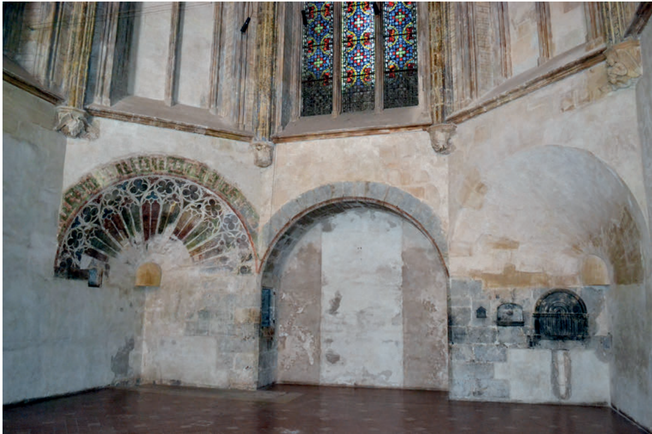
6 - Palais des rois de Majorque, chapelle haute, trompes d'angles.
