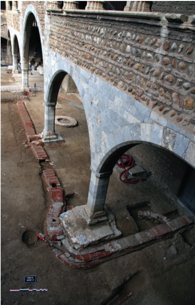
31 - Le caniveau CN 2009 / 2010, qui rejoint le puits de décantation nord.
