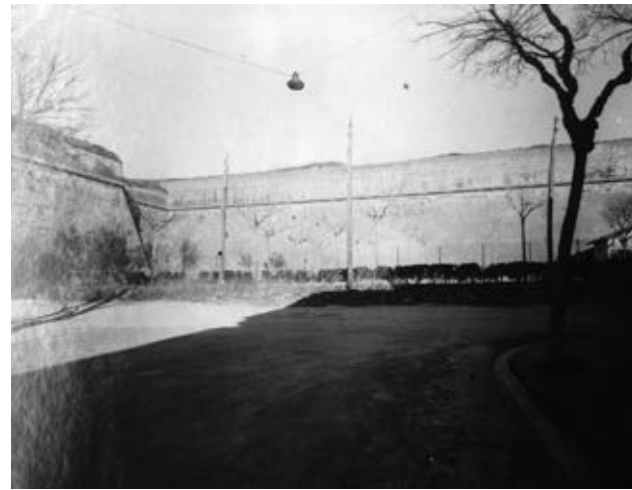
29 - La courtine de la citadelle avant le percement du nouvel accès.
