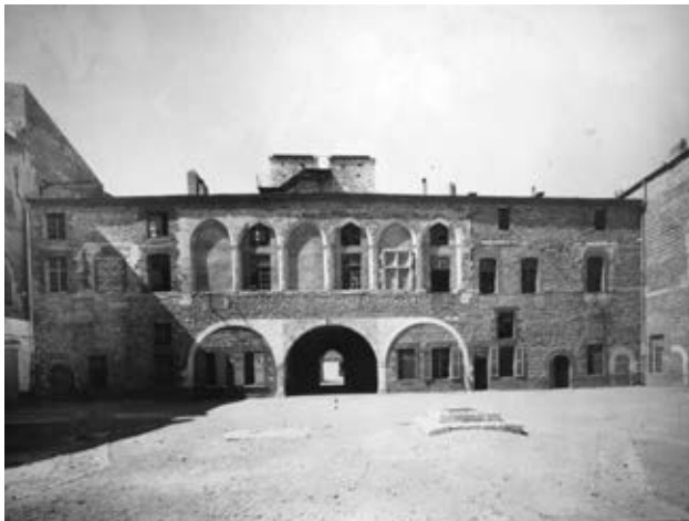
10 - Façade de l'aile ouest sur la cour, après piochage des enduits. Photo Comet, 1947.
