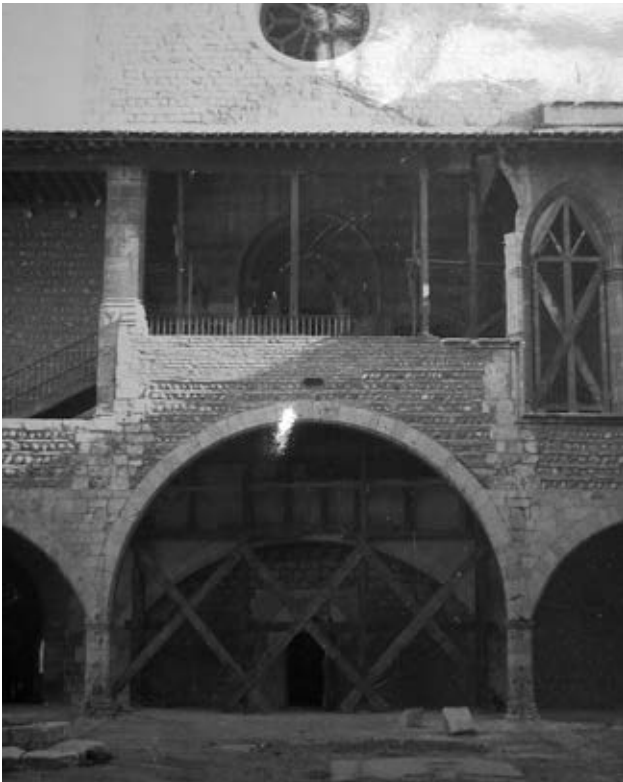
14 - Décembre 1949. Après démontage du pilier buttant de l'extrémité de la galerie, la mouluration du pilier primitif et le négatif du départ de l'arc apparaissent. Photo Stym-Popper.
