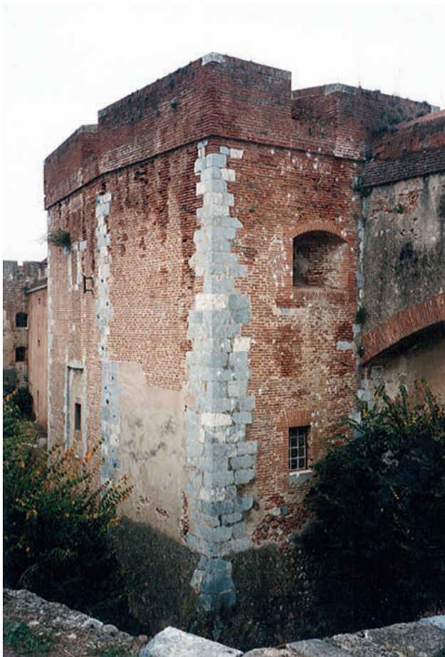
6 - Front sud, tour sud-est, détail de l'angle, état 1996 (cl. de l'auteur).
