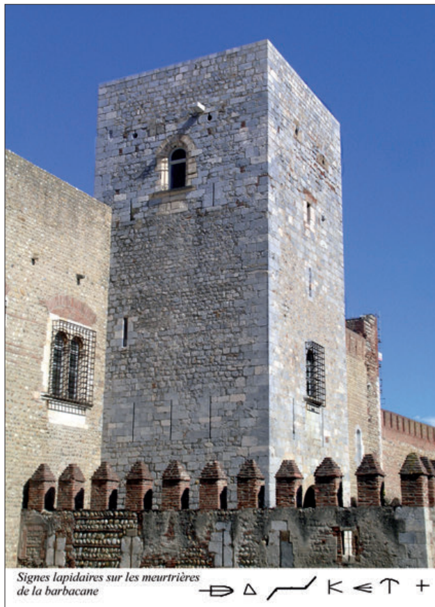
20 - Tour de l'hommage, face nord très chargée en calcaire cristallin bleu et en brèches sombres de Baixas. La partie intermédiaire au-dessus du rez-de-chaussée est réalisée avec des assises plus ou moins régulières de moellons équarris éventuellement destinés à être dissimulés sous un enduit. Cet appareil semble être celui d'origine, contrairement à celui de la façade ouest, sans doute fortement perturbée par l'impact des boulets lors des sièges contre la garnison française en 1463 et 1475.
