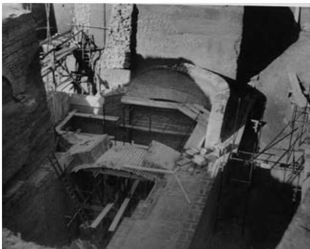
30 - La construction du nouvel accès, janvier 1957. Photos Stym-Popper.
