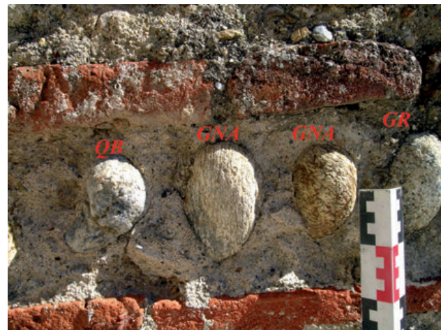
4 - Parapet du pont d'accès au château royal. Pris dans le mortier caractéristique de la construction médiévale, un rang de petits galets typiques des phases anciennes du chantier dont les quartz blancs (QB) et les granites (GR) présentent une surface de roulement fraîche (M7, tableau 4). Les gneiss (GNA) ont par contre subi une première phase d'altération qui commence à ouvrir les fissures ou qui colore l'un d'eux.
