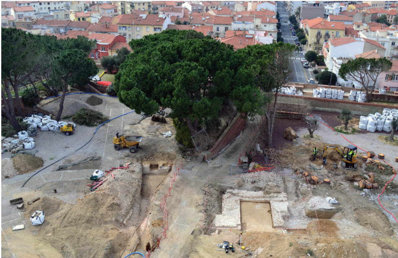
53 - Vue générale des jardins du palais en cours de travaux. On distingue au centre le porche, à droite le tracé du rempart et au-dessus, dans la tranchée, le mur de contrescarpe qui maintient la rive ouest de l'ancien fossé.
