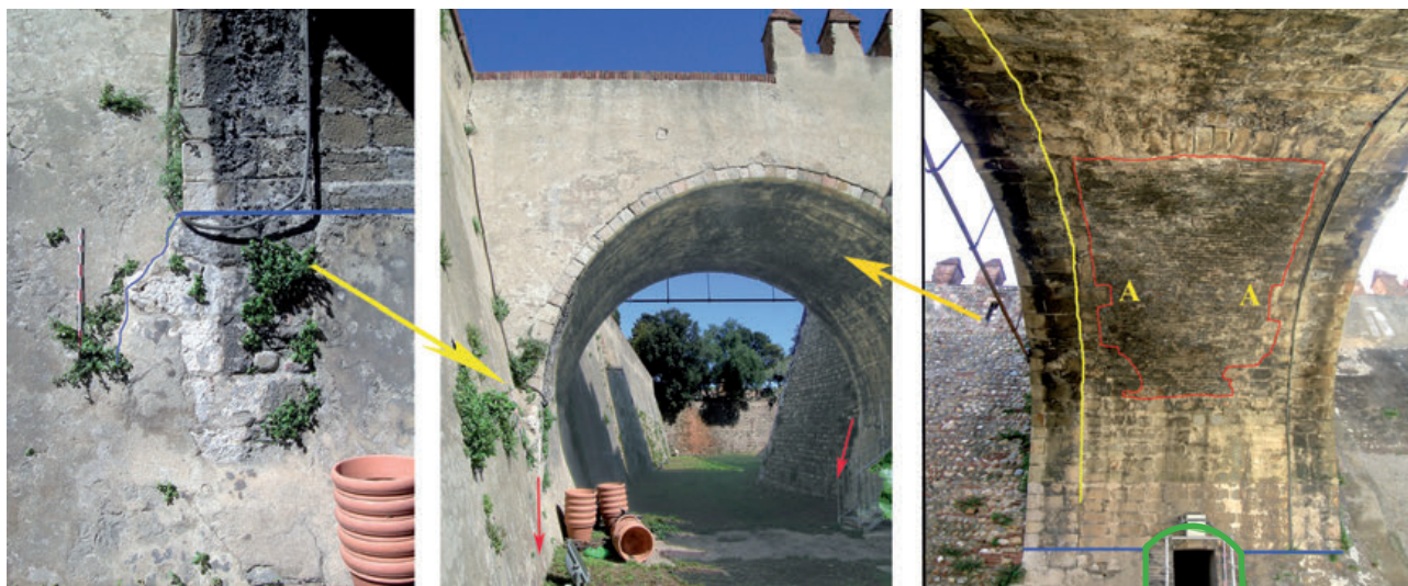
13 - Vues du pont-levis en avant de la courtine, depuis le fossé (au centre, les flèches rouges indiquent le pendage des chaînages de la culée et ceux du pilier, à gauche). Sur la vue de droite, prise en dessous, le trait bleu matérialise la partie basse, faite en marbre de Baixas, le trait jaune une des deux arches construites séparément avant la voûte et le trait rouge l'évidement comblé avec de la brique pour le pont-levis en bois. L'existence d'une avancée des parements qui encadrent le vide (A) suggère la présence d'un axe pour un possible pont basculant, pas forcément encastré au-dessus dans le portail du porche. L'existence sur le pont d'un passage piéton possible de chaque côté du vide explique que le parapet venait en biais buter de part et d'autre sur cette limite pour bloquer cet accès, ce qui est visible sur les photos de 1945, avant restauration (Alazet 2005, p. 72 et Martzluff et al. , cet ouvrage, ill. 5). Le passage souterrain qui fait communiquer la barbacane avec le fossé (encadré en vert) est post-médiéval (escalier en briques peu usées, blocs de basalte en remploi dans les murs).
