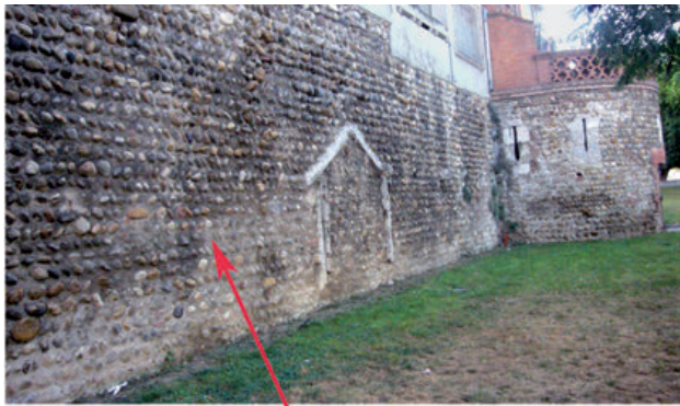
8 - Jonction du rempart de la ville avec le château royal. Les petits galets de gneiss sont représentés à la base de la courtine, près de la mire (M2), alors que de plus gros galets de quartz patinés apparaissent au-dessus de l'encadrement de la meurtrière en brèche bleue de Baixas. Les briques qui jouxtent les angles des linteaux sont des ajustages lors de la pose, probablement effectuée dans un orifice d'attente. La partie supérieure (M3, au-dessus de la flèche verte) se signale par un mortier plus fin et brun avec une utilisation massive des quartz patinés.
