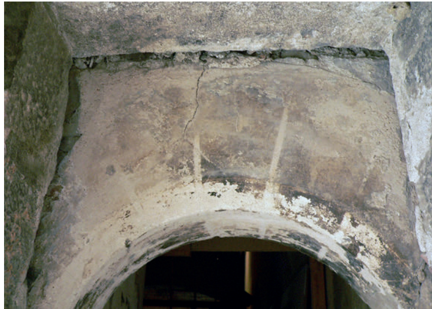
25 - Vestige d'enduit de façade à faux claveaux peints dans la tour-contrefort sud. Cl. A. Marin.
