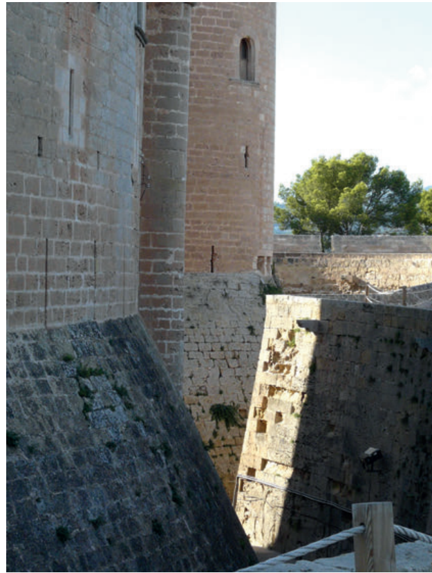
37 - Superfícies corbades dels murs, torres i talussos del castell de Bellver.
