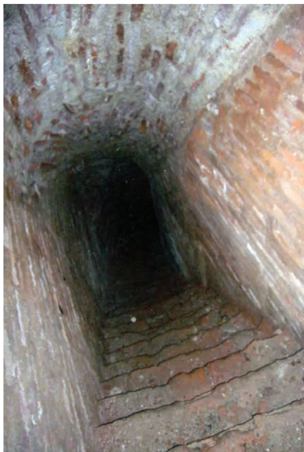
41 - Départ du souterrain, depuis la salle du moulin à huile. Plus bas, la galerie est murée et probablement en partie effondrée.
