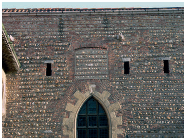
41 - Détail de façade sur cour de l'aile sud montrant les fenestrons. Cl. A. Marin.
