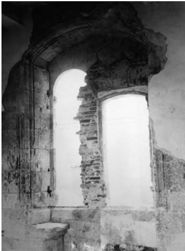
24 - Une fenêtre en cours de dégagement (vue de l'intérieur). Photo Stym-Popper.
