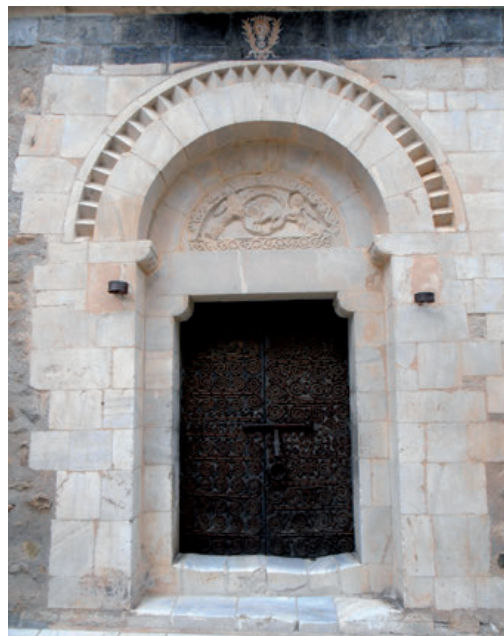
37 - Sur la vue de gauche, portail de l'église de Saint-Feliu-d'Amont et son tympan sculpté. Seuls quelques blocs de marbre du seuil sont chargés de bleu, le reste et les montants sont en marbre cipolin, mais discrètement rubané en tenant compte de la patine. L'encadrement du tympan est plus uni dans le blanc et pourrait témoigner d'une importation. Sur la vue de droite, portail de l'église du château d'Ultrera (reconstitution fantaisiste sur la façade de l'ermitage de N-D du château). Le marbre cipolin est ici très chargé de lamines bleues et de stries ou de zébrures, dont beaucoup sont brunes et affectées de la même patine sale observée au palais, comme sur le bloc sommital en particulier (cl. C. Respaut, AAPO).
