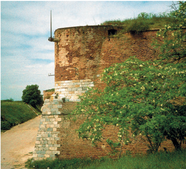
15 - L'avancée défensive, détail du bastion sud-est, ensemble en brique, angle en pierre de taille de Baixas, avec l'épée en place, état 1993 (cl. de l'auteur).
