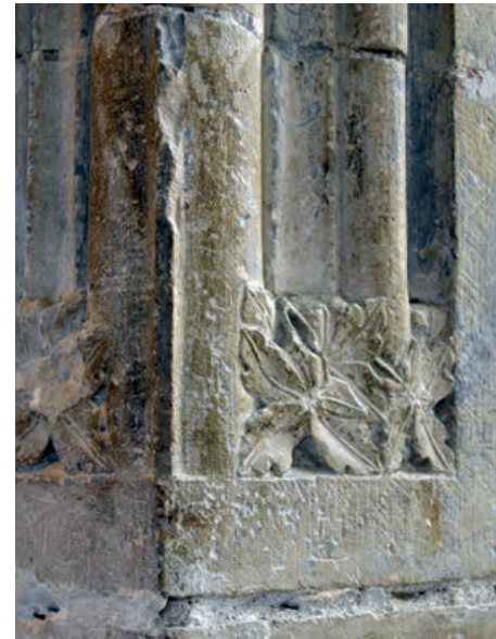
18 - Majorque, palais de l'Almudaina, baie de la grande salle du premier étage, jambage vu de l'intérieur avec dans la partie basse de l'ébrasement des feuillages accolés à la modénature.
