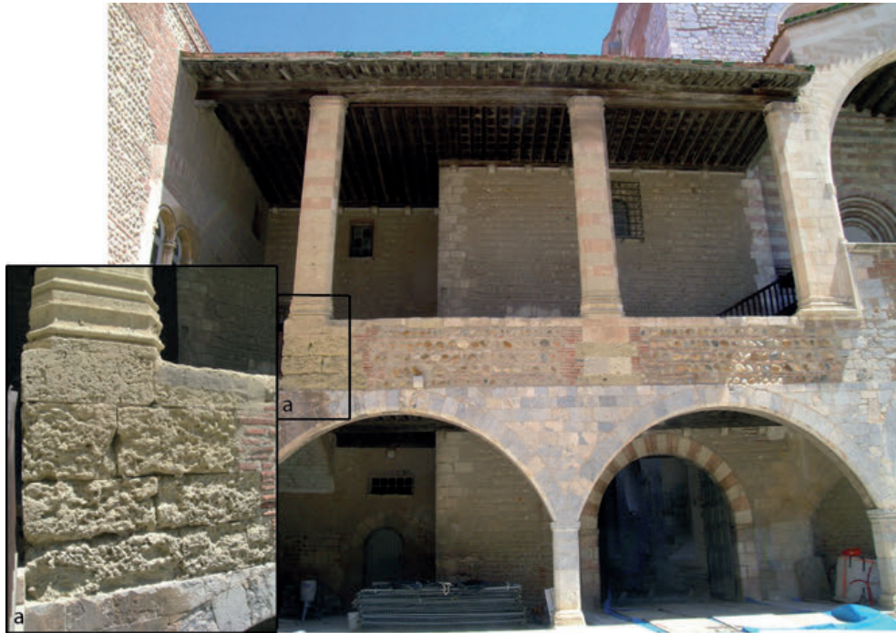
24 - Façade orientale de la cour d'honneur où on peut observer les différents matériaux utilisés pour construire le château royal de Perpignan. Les colonnes modernes quadrangulaires en molasse à grain fin qui soutiennent le toit de la galerie sont réputées avoir été édifiées à des époques largement postérieures à celle de la construction première; elles sont bien conservées alors que le mur sous-jacent construit avec une molasse à grain grossier et à nombreuses coquilles d'huîtres s'est considérablement dégradé (encarté a). Le pilier à gauche reçoit les poussées de l'escalier et des voûtes de la galerie construits en grès du Boulou, on peut aussi noter l'agencement typique des galets et des briques et le portail bicolore F5 d'époque moderne en marbres rouge et blanc dont on ignore la provenance.
