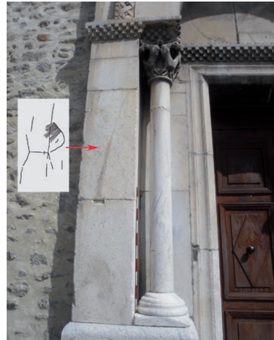
41 - Portail de l'église du Boulou avec son marbre blanc discrètement rubané de bleu. Est figurée sur le montant gauche une ébauche de personnage visible dans des traces noires (mine de plomb?).
