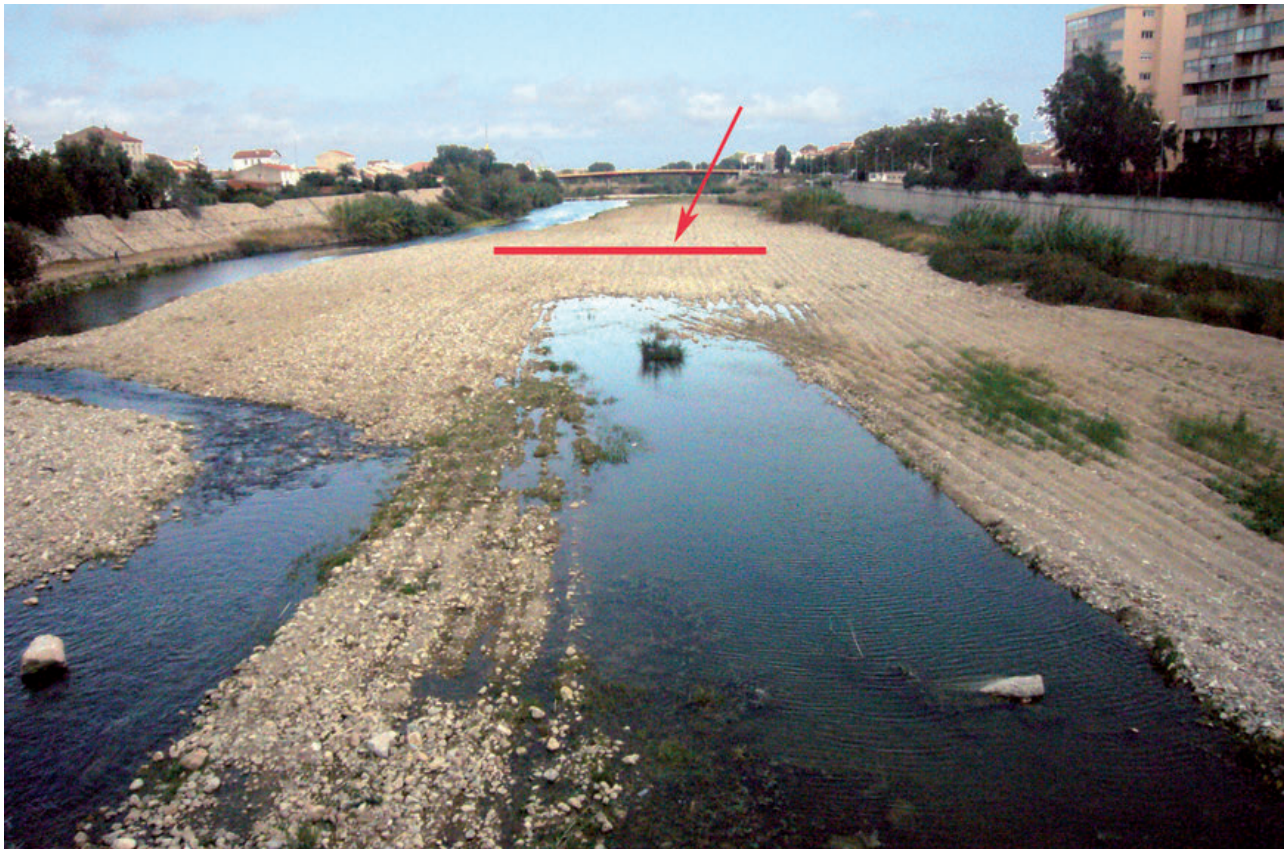
2 - Nappe alluviale actuelle de la Têt à Perpignan lors de l'étiage 2011. Le secteur testé est représenté par le trait rouge et les sillons ont été réalisés par un engin mécanique, favorisant la bonne répartition des galets en surface. Sauf indication contraire, tous les clichés et DAO sont des auteurs.
