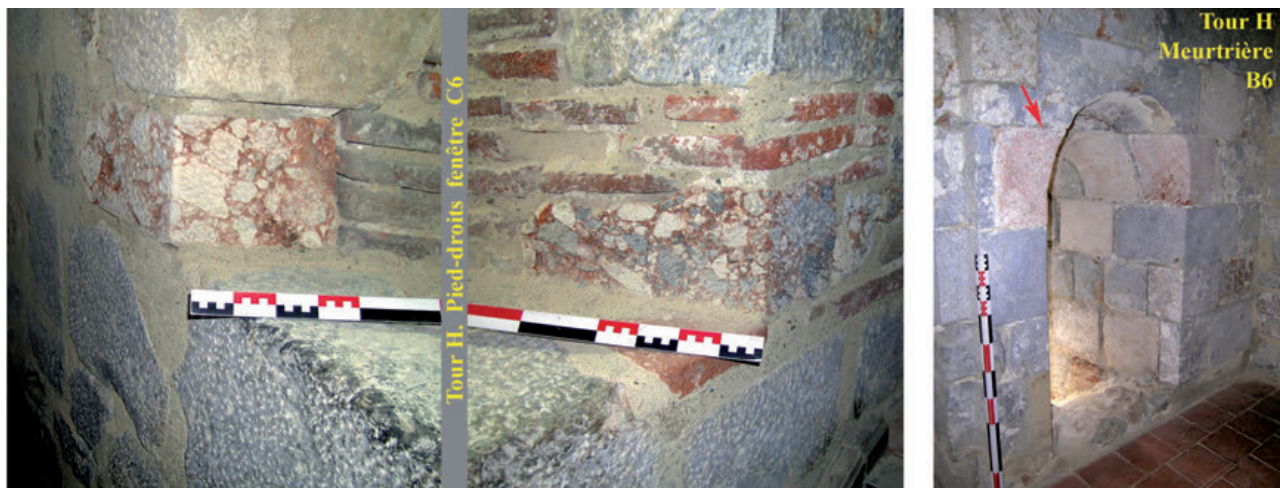
24 - Décoration des ouvertures dans la tour de l'hommage avec une « brèche romaine » de Baixas à ciment rouge, proche des marbres de Caramany. On remarque aussi l'usage extensif du marbre bleu foncé de Baixas.
