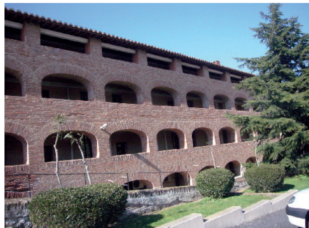
32 - Façade de la caserne vieille, état actuel (cl. O. Passarrius).
