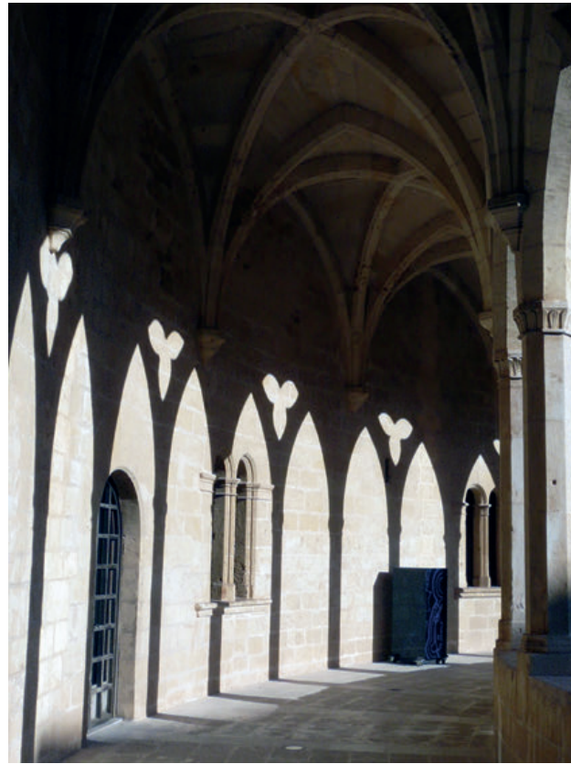
28 - Voltes i pilars de la galeria superior del castell de Bellver.
