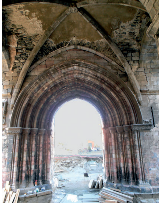
53 - Église Sainte-Marie de Puigcerdà, le portail gothique en marbre rose et rouge d'Isovòl placé sous le porche du clocher-tour (cl. C. Respaut, AAPO).
