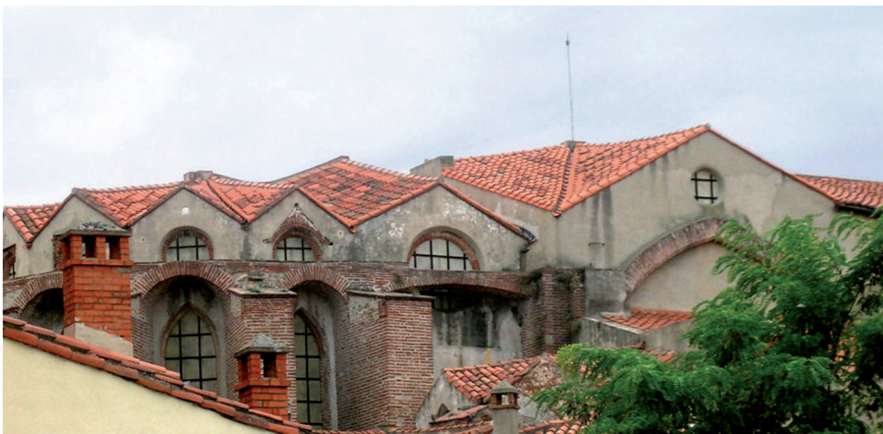
26 - Vue d'une partie du chevet de l'église des Dominicains dans sa partie construite à l'extrême fin du XIII e siècle et achevée en 1316 (Barrenechea, cet ouvrage). Contemporaine de la fin des travaux au château royal, cette construction fait intervenir massivement la brique au côté de quelques armatures intérieures en brèche de Baixas (croisées d'ogives, colonnettes, clefs, culots...). On remarquera l'omniprésence de la terre cuite sur les contreforts dont les curieux arcs bandés situés entre les lancettes des longues ouvertures et les oculi , pareillement réalisés en briques moulurées. À droite, le grand arc brisé marque l'emplacement de la voûte effondrée du transept. Une influence venue d'Aquitaine, où ce matériau bénéficie d'une longue tradition architecturale, a été notée pour cette partie du monument (église des Jacobins, à Toulouse par exemple). Toutefois, l'emploi quasi exclusif de la brique en Roussillon, dès les années 1300, et probablement aussi le remplacement systématique des ardoises sur les toits par des tuiles, à la fin du XIII e siècle, est principalement imputable à un essor des briqueteries et des tuileries lié aux mécanismes que nous avons évoqués dans ces pages, bien plus sans doute qu'à un effet de mode, même si le savoir-faire de cet artisanat dans le sud-ouest a pu jouer un rôle en la matière. Notons par ailleurs que la production de briques et de tuiles à Perpignan a pu connaître par la suite de grosses difficultés, en particulier après 1350, avec l'arrêt de gros chantiers de construction, comme celui de la nouvelle église Saint-Jean par exemple. C'est ce que semble indiquer l'importante commande de 6 000 rajoles de Barcelone faite en 1403 par le roi d'Aragon pour des réparations urgentes au Château royal (ADPO 1Bp 369, cité dans Marin et al. , vol. 1, p. 91).
