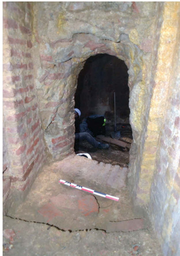
68 - La porte aménagée dans la paroi du silo lors de sa transformation en puits à glace.
