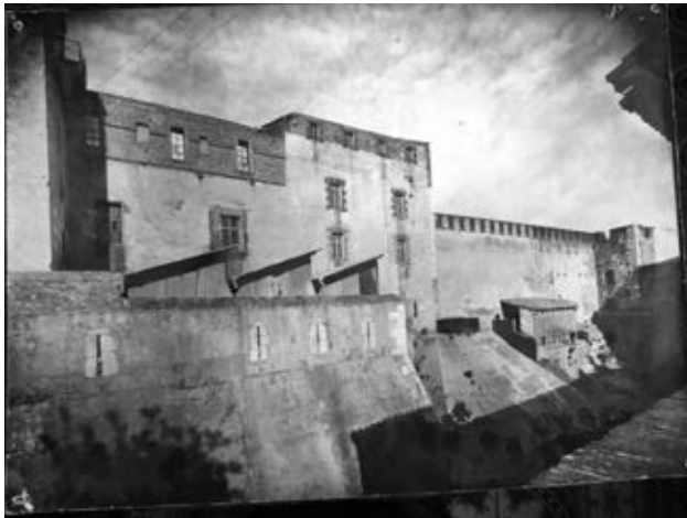
8 - Façade extérieure ouest du palais (partie sud), avant restauration. Photo Comet, 1947.
