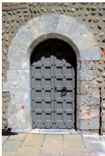
20 - Tour de l'hommage, face nord très chargée en calcaire cristallin bleu et en brèches sombres de Baixas. La partie intermédiaire au-dessus du rez-de-chaussée est réalisée avec des assises plus ou moins régulières de moellons équarris éventuellement destinés à être dissimulés sous un enduit. Cet appareil semble être celui d'origine, contrairement à celui de la façade ouest, sans doute fortement perturbée par l'impact des boulets lors des sièges contre la garnison française en 1463 et 1475.
