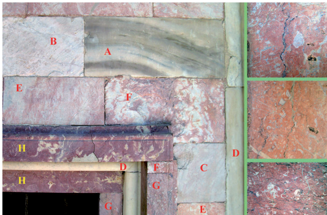
35 - Façade de la chapelle Sainte-Croix. À gauche, aspect des matériaux avec les marbres blancs représentés par le marbre cipolin local du Primaire, très chargé de brun et de gris (A) ou simplement moucheté de bleu (D), les marbres blancs de Baixas (B et C). Les marbres rouges sont représentés par des variétés rosâtres chargées de calcite blanche (E) ou du marbre « MVF » classique (F), voire des marbres rouges ou orangés plus unis et fossilifères (G : détail sur la colonne de droite). Les marbres pourpres étrangers au substrat (H) forment les linteaux de la fenêtre.
