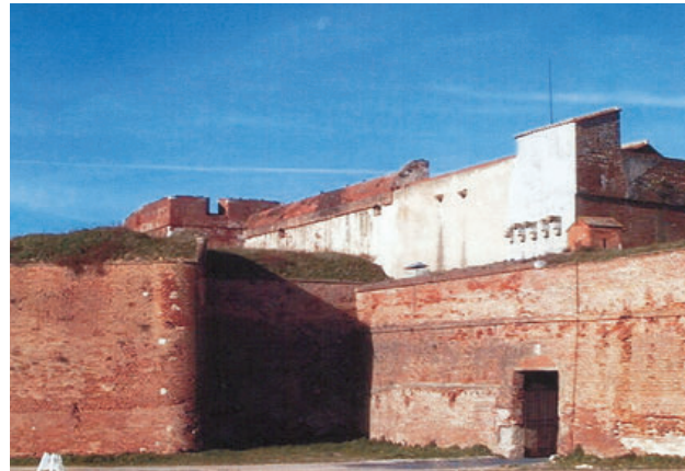
8 - Front sud, ensemble de l'angle sud-est. À gauche, au premier plan, l'orillon du bastion sud-est de l'avancée défensive et la jonction avec la courtine; au fond, le sommet de la tour sud-est, le parapet au profil en quart de rond et les corbeaux vestiges d'un flanquement disparu; en arrière à droite, on aperçoit la pointe du pignon du bâtiment de l'angle sud-est en brique de la figure 3 (Archives du service territorial de l'architecture et du patrimoine des Pyrénées-Orientales).
