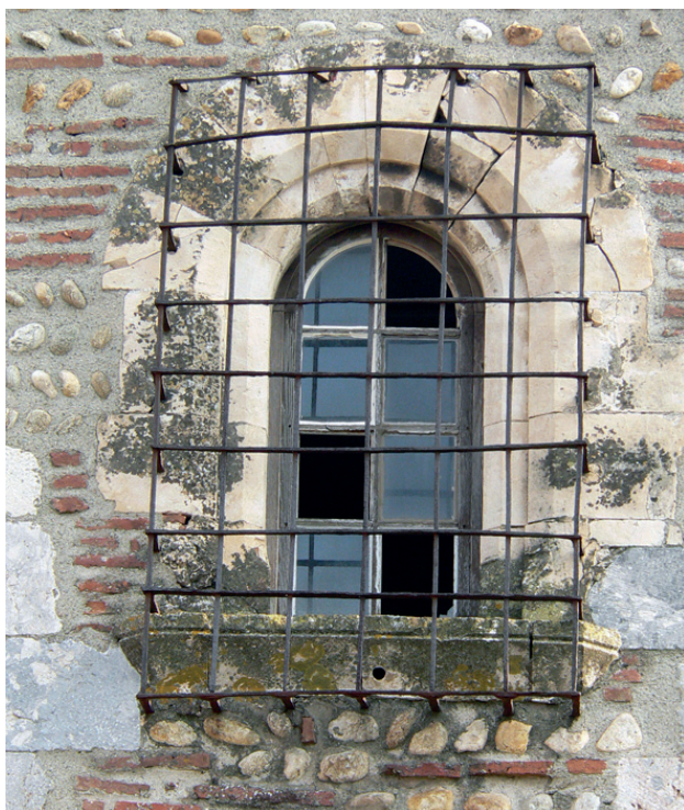
23 - Fenêtre en plein cintre à double ressaut et sa grille. Sommet de la tour d'angle nord-est, face nord. Cl. A. Marin.
