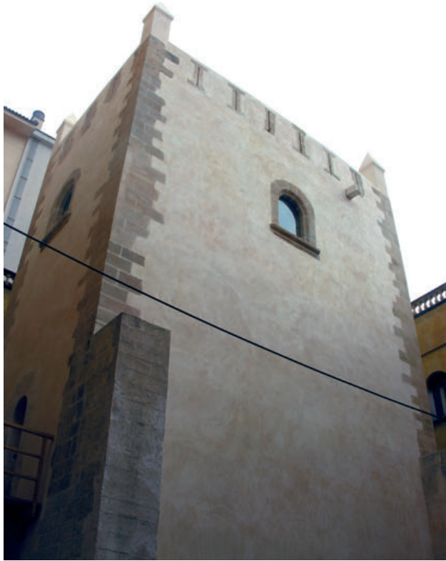
13 - Aspecte actual de la torre del palau de Manacor (Mallorca), després de les restauracions del 2010.
