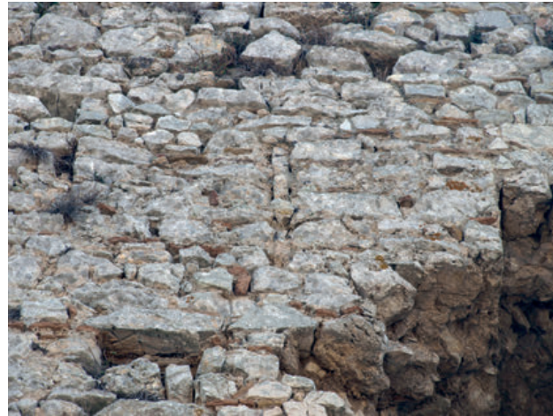
41 - Chloumoutzi-Clermont, hexagone, merlon percé d'une archère.
