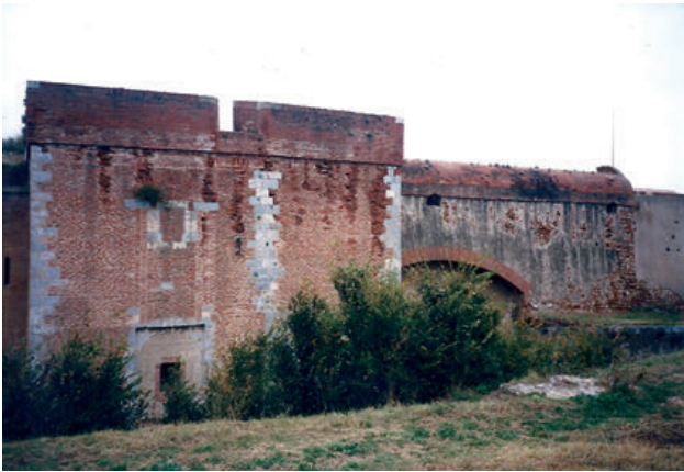
7 - Front sud, à gauche, élévation de la tour sud-est, à l'arrière-plan, l'arc de décharge et la courtine, état 1996 (cl. de l'auteur).
