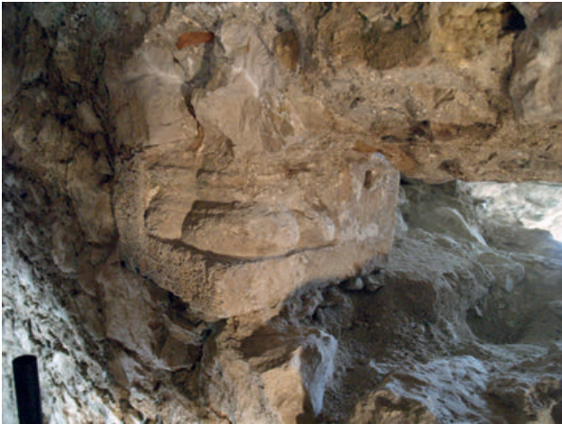
19 - Chloumoutzi-Clermont, hexagone, base des colonnettes du piédroit de la fenêtre au-dessus de la porte.
