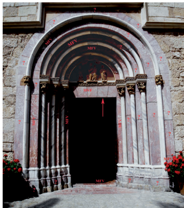
57 - Portail de la chapelle Sainte-Anne, au palais de l'Almudaina, à Palma de Majorque, avec sa légère levée de seuil et son curieux linteau en plate-bande appareillée sous le tympan (flèche rouge). Les points d'interrogation indiquent les parties du marbre rouge dont la tonalité violette tranche avec le reste, surtout à la base du portail.
