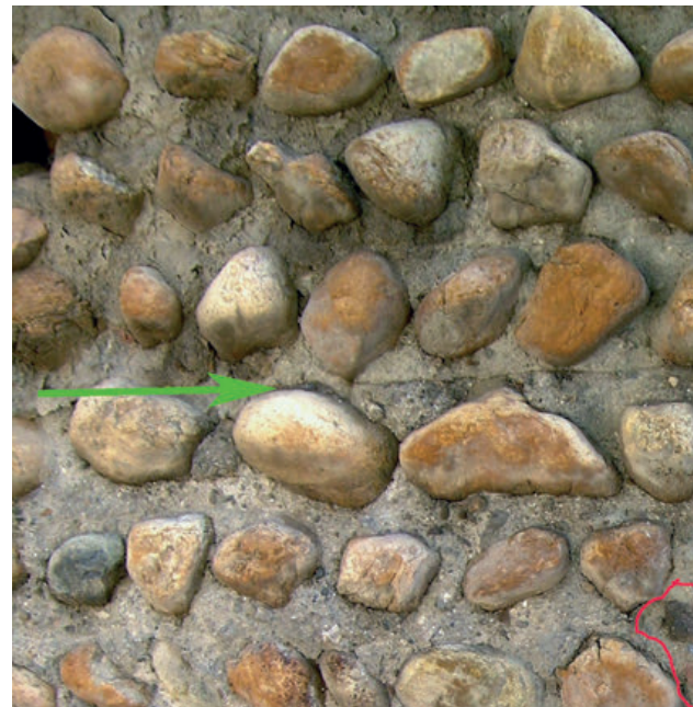
8 - Jonction du rempart de la ville avec le château royal. Les petits galets de gneiss sont représentés à la base de la courtine, près de la mire (M2), alors que de plus gros galets de quartz patinés apparaissent au-dessus de l'encadrement de la meurtrière en brèche bleue de Baixas. Les briques qui jouxtent les angles des linteaux sont des ajustages lors de la pose, probablement effectuée dans un orifice d'attente. La partie supérieure (M3, au-dessus de la flèche verte) se signale par un mortier plus fin et brun avec une utilisation massive des quartz patinés.
