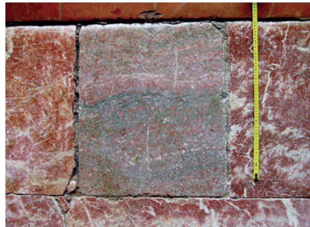
29 - Pavement en plaques de marbre à l'entrée de la chapelle haute. On reconnaît les faciès rouge flammé du marbre de Villefranche-de-Conflent qui encadrent une plaque rose et verte (veines de calcite pigmentées par la chlorite) caractéristique du faciès dit « fleur de pêcher de Villefranche » (ou de Ria), attestant ainsi de la probabilité d'une origine géographique commune de ces matériaux.
