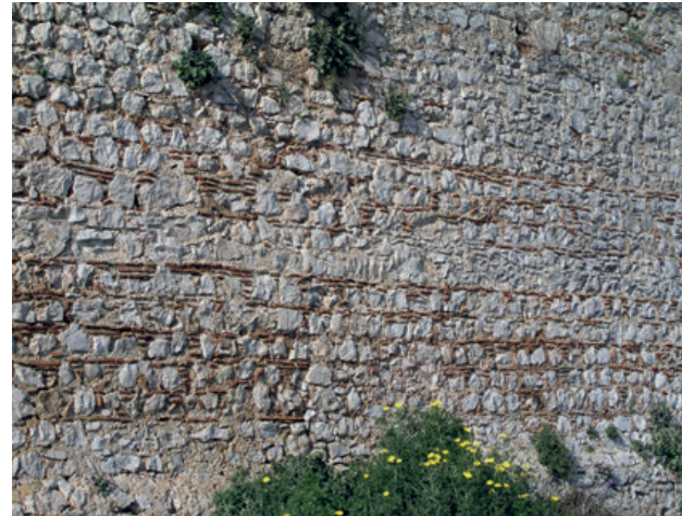
48 - Chloumoutzi-Clermont, appareil irrégulier.
