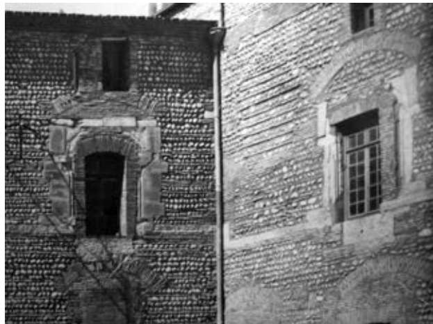
12 - Angle des façades de l'aile ouest et de l'aile nord sur la cour, après piochage des enduits : détail de l'étage : les baies du XIV e s. dans leur état partiellement détruit. Photo Stym-Popper.
