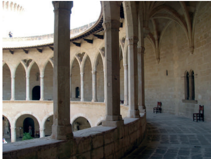
51 - Château de Bellver. Galerie à arcatures sur portique et type de baie. Cl. B. Pousthomis.
