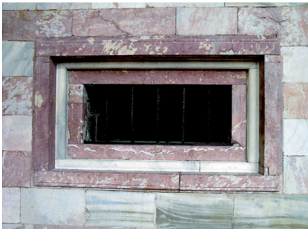
28 - Encadrement en marbre rouge flammé de Villefranche-de-Conflent et d'une variété à pigmentation carminée proche du violet de Ria d'une ouverture latérale au portail d'entrée de la chapelle haute; l'ouverture est sus-jacente à un alignement de marbre blanc ou gris de Céret caractérisé par ses séquences gris-verdâtre.
