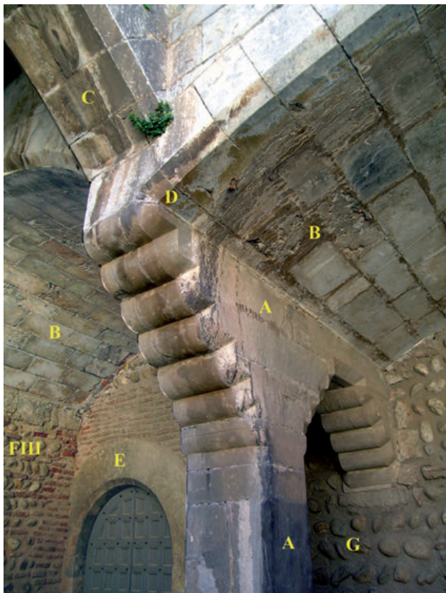
12 - Pilier de l'escalier sud de la cour d'honneur en grès siliceux du Boulou avec ses avancées typiques en tas de charge (A). Ce pilier reçoit la poussée des voûtes de l'escalier en marbre de Baixas (B), gravées de minuscules signes lapidaires, et celle des voûtes basses de la galerie des chapelles (C), ainsi que celle du pilier de la galerie haute, juste au-dessus. Le sommier (D) est en marbre de Baixas, comme la porte E, visiblement antérieure au mur FIII de séparation des cours. On remarquera la différence entre les murs anciens montés en galet (G) et le plus récent (FIII) munis de chaînage de briques.
