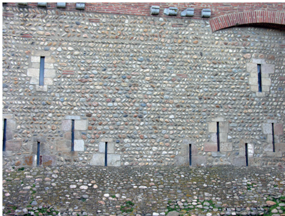
45 - Jours et fentes de tir du rez-de-chaussée dans la maçonnerie de galets. Cl. B. Pousthomis.
