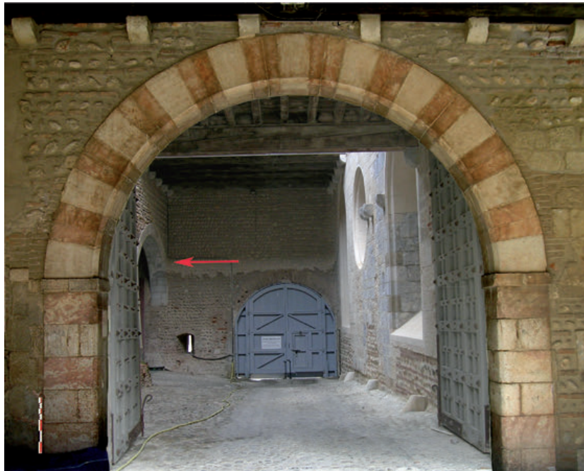
58 - Portail F5 de la cour d'honneur au Palais des rois de Majorque de Perpignan. Au fond la courtine où fut ouvert le portail en briques qui débouche sur le pont dormant donnant accès à la caserne. La flèche rouge pointe la grande arcade majorquine en brèches de Baixas (cl. C. Respaut, AAPO).
