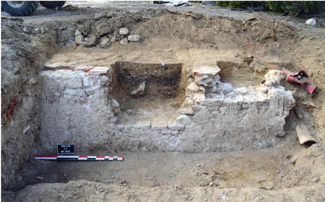
56 - Détail du mur de contrescarpe.
