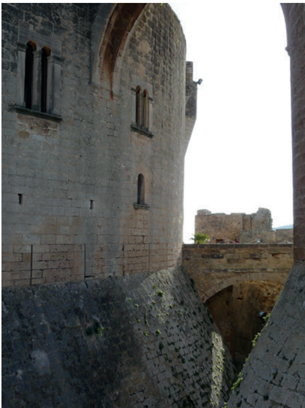
26 - Talussos i mur perimetral del castell de Bellver.
