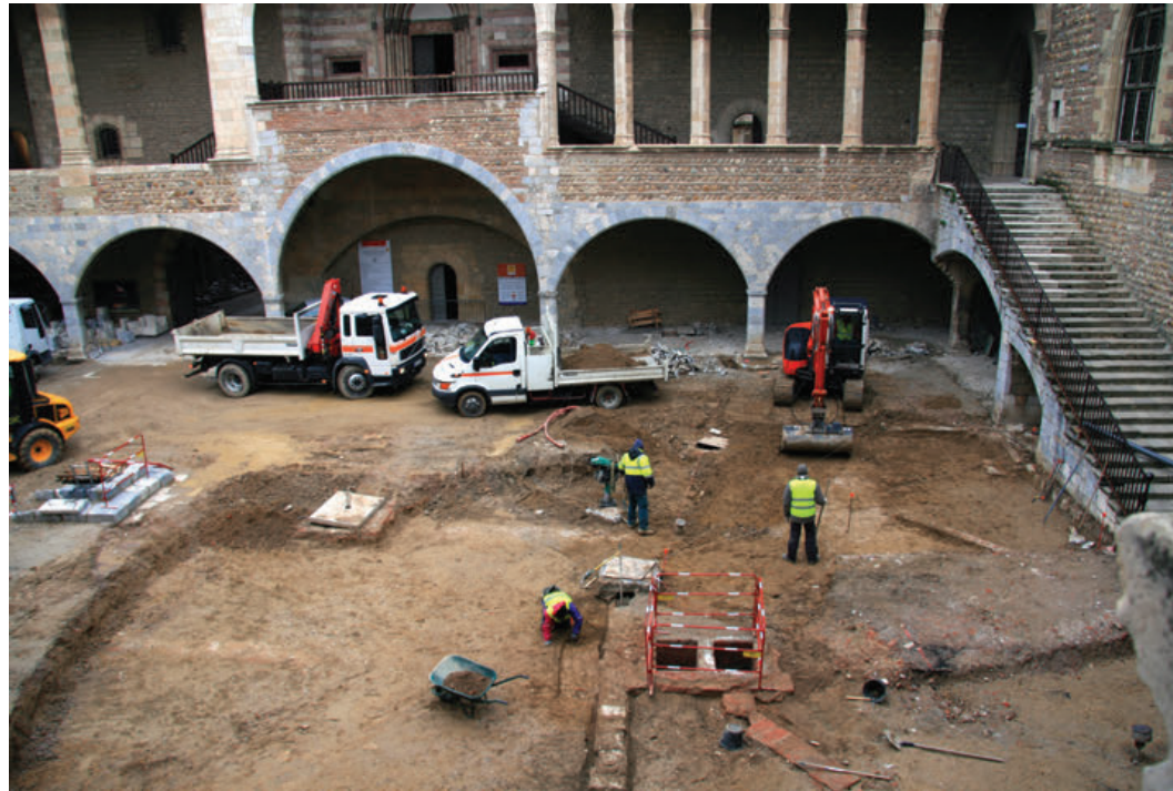
8 - Le décapage de la cour, sous surveillance archéologique.
