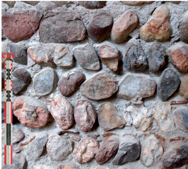
23 - Église des Carmes, détail du gros œuvre. Le mur de la façade occidentale (à gauche) comporte de gros galets de quartz cassés au marteau et quelques calages de tuiles. Sur la façade nord de la première chapelle (à droite), les galets de quartz patinés sont disposés en plusieurs rangs entre des assises de briques sans être forcément associables au montage : entre deux arases de briques s'observe un net changement dans la couleur du mortier (flèche bleue) et un litage de cales en tuile (flèche jaune) sous le dernier rang (cl. C. Respaut).
