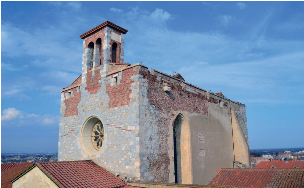
Emplacement de l'inscription de 1829 sur le côté sud du clocheton de la tour des chapelles. Restaurée en 2013.
