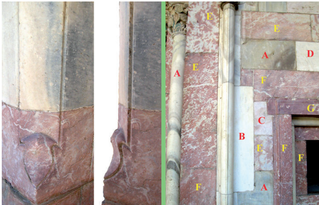
34 - Façade de la chapelle Sainte-Croix. À gauche, congé du chanfrein de face et de profil sur le mur de l'avancée nord. À droite, aspect des différents matériaux des assises « blanches » avec des marbres fini-précaimbriens très oxydés (A) ou au contraire très blancs à patine ivoire (B), mais aussi la « brèche romaine » (C) ou les marbres de type « Estagel » (D) de Baixas et, d'autre part, pour les assises rouges, avec les marbres « MFV » (E), plus ou moins chargés de blanc, parfois très compacts (F) ou de couleur pourpre, et étranger au substrat local (G).
