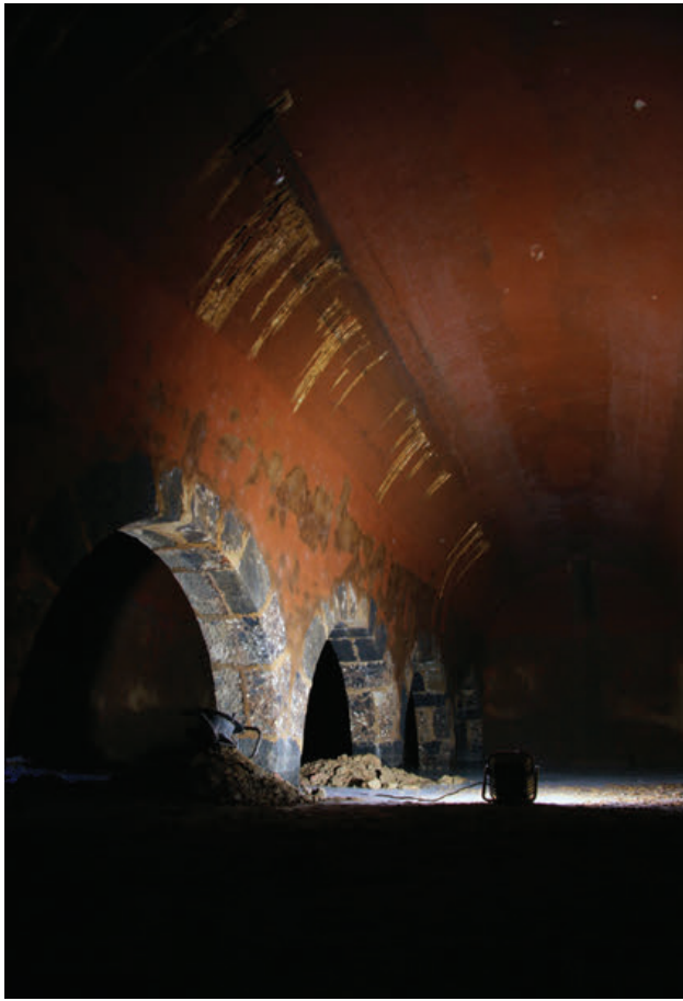
9 - L'une des travées de la grande citerne, enduite de mortier de tuileau.
