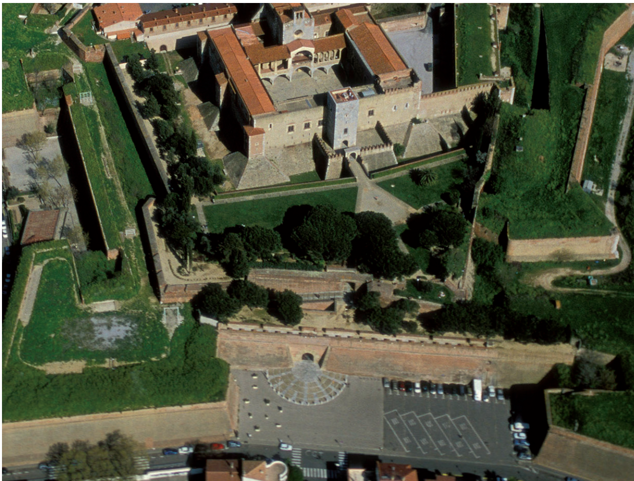
32 - Vue aérienne du palais montrant l'entrée et le nouvel accès. © F. Hedelin.
