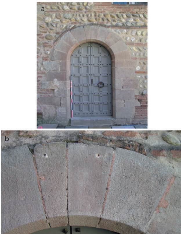
4 - Exemple d'emploi des grès siliceux de Mollars ou grès du Boulou dans l'architecture. a. Porte de l'aile orientale donnant sur la cour d'honneur. Le même modèle de porte se répète dans la brèche orientale de Baixas; b. détail de la porte sur la voûte, avec son signe lapidaire.
