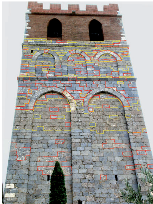
30 - Le clocher-tour de l'église fortifiée d'Espira-de-l'Agly, façade ouest. Les brèches post-albiennes mouchetées de blanc de Baixas sont entourées de rouge (certaines pouvant éventuellement provenir de restaurations récentes). Les autres brèches à ciment brun vacuolaire, très dégradées par la dissolution, sont cerclées de jaune. On remarquera, en bas sur la gauche, deux parements d'angle en marbre blanc, vague rappel du décor initial. Une partie des claveaux de l'arcature de gauche semble taillée dans un calcaire blanc saccharoïde comparable dans sa qualité (et son mode d'érosion) à celui de l'église romane la plus ancienne, ce qui est pour le moins étonnant.
