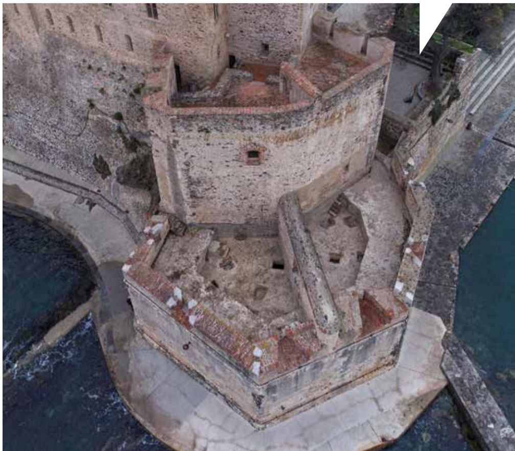
Vue du bastion de la mer une fois dégagé. On distingue la terrasse inférieure avec les événements qui permettaient d'aérer les salles souterraines. 200 m 3 de gravats ont été évacués.
