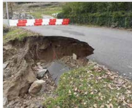
Ce trou, situé sur la route départementale qui relie les bains de Molitg au village, a été causé par les eaux de ruissellement, ce qui a conduit à l'effondrement d'une partie du remblai routier et de la chaussée.
