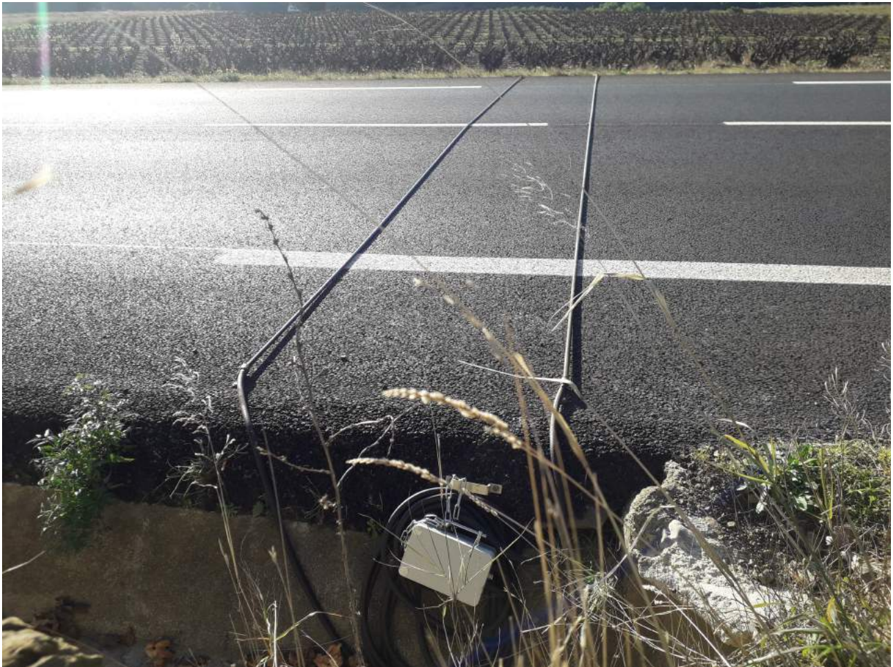
3. Illustration: Pose de tubes pneumatiques sur chaussée. Le boîtier est en gris sur l'image
