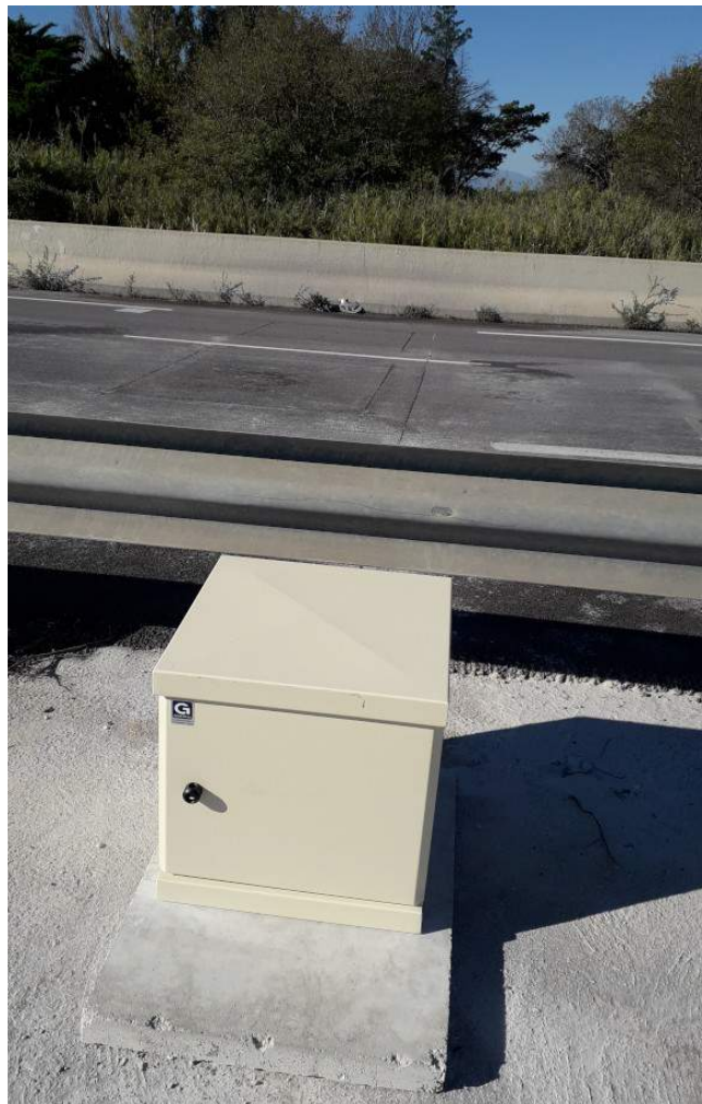
2. Illustration: Logette et boucles électromagnétiques pour comptage tournant
