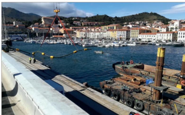
Pose du rideau à bulles d'air mobile, procédé innovant qui permet la continuité d'exploitation pendant les travaux
