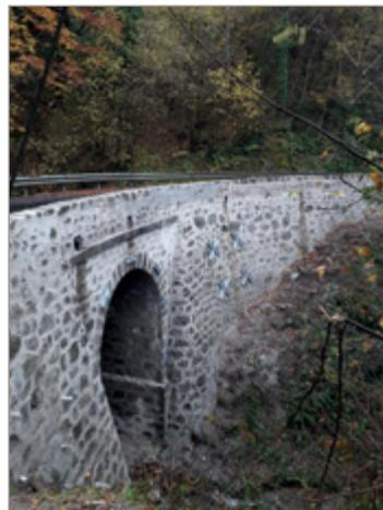
La première étape d'entretien de ces ponts consiste à enlever la végétation. C'est la condition sine qua none au contrôle visuel. Ensuite vient l'entretien des joints de surface : tous les 10 ans environ, ce joint se détériore, il est nécessaire de nettoyer ce qui reste puis de refaire le joint à neuf.
