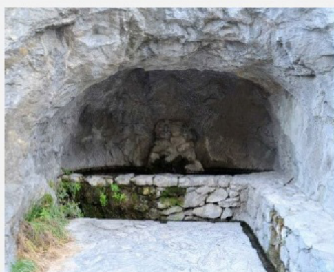
☞ Photographie : Emergence captée et aménagée en rive gauche
