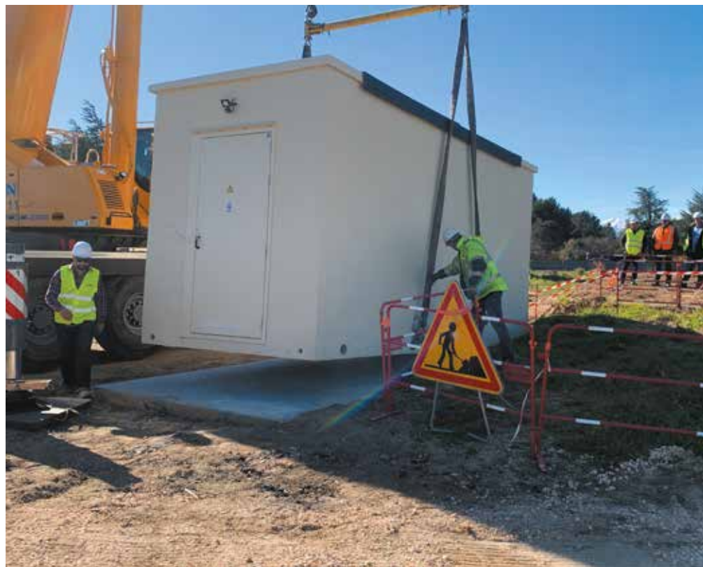
Pose d'un Nœud de raccordement optique (NRO) à Argelès-sur-Mer. Étape indispensable à l'arrivée de la fibre dans les foyers.
