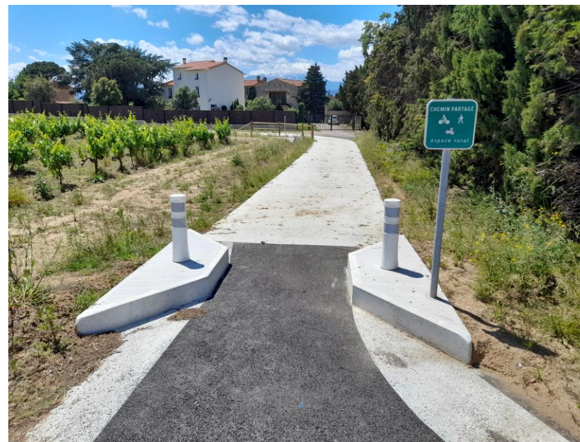
Resserrement béton, Villemolaque
