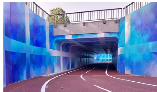
Figure 55 Passage inférieur créé sous un giratoire. Piste cyclable reliant La Mézière à Rennes, Département d'Ille-et-Vilaine.
