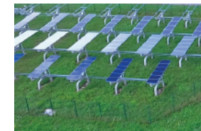
EDF Renouvelables Centrale solaire photovoltaïque sur trackers
