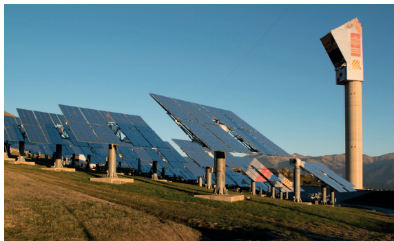
CNRS PROMES Centrale solaire thermodynamique à tour
