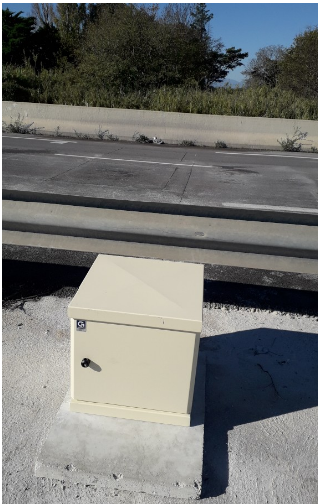
1. Illustration: Logette et boucles électromagnétiques pour comptage tournant
